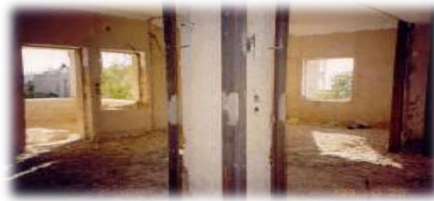
Figure II.17 : Renforcement de poteaux au moyen de profilés métallique
