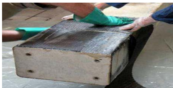
Figure II.23 : Chemisage d'un poteau par PRFC.
