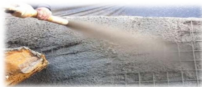
Figure II.5: Renforcement d'une poutre au moyen de béton projeté
