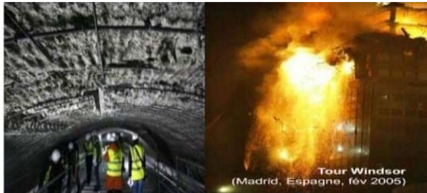
Figure I.3 : Tunnel sous la manche en phase de réparation à la suite de l'incendie septembre 2008.
