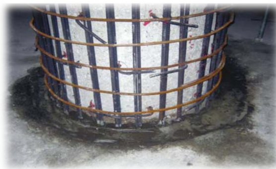
Figure II.9 : Chemisage en béton armé
