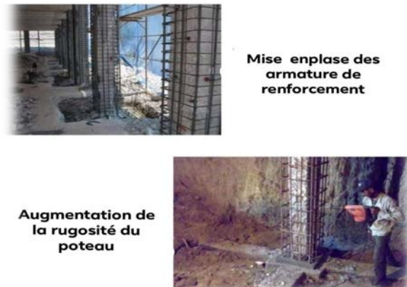
Figure II.10 : Chemisage en béton armé
