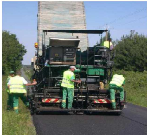
Figure 1.2: Technique de l'asphalte caoutchouté
