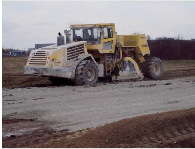
Figure 2.9: Chantier de traitement du sol au ciment
