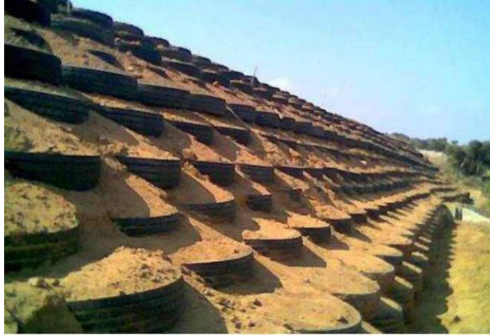
Figure 1.9: Chantier expérimentale Pneu sol à Bou-Ismaïl (Trouzine et al. 2010)
