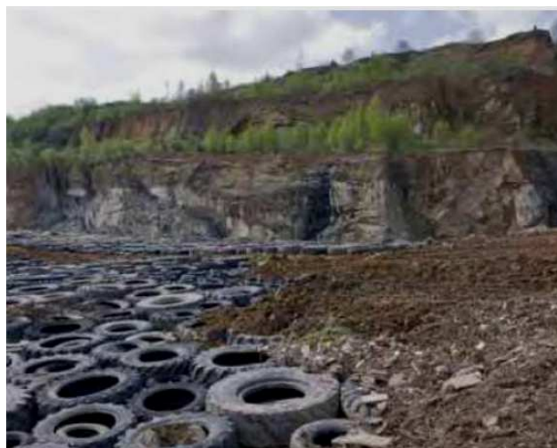
Figure 2.12: Ouvrage en pneus anti-érosion
