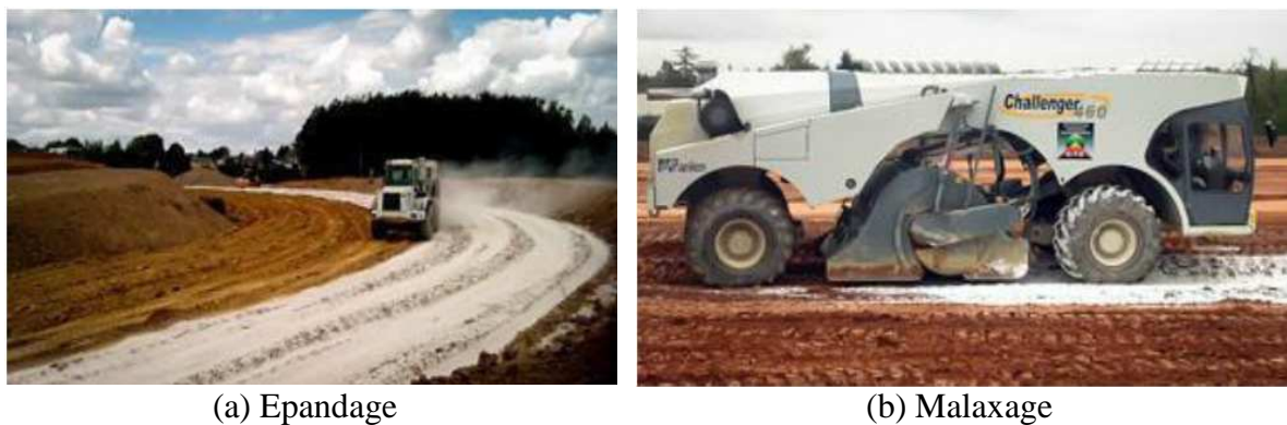
Figure 2.8: Chantier de traitement d'un sol à la chaux
