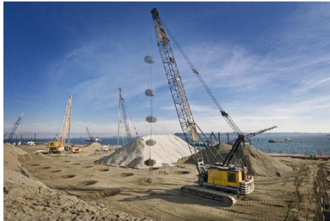
Figure 2.5: Chantier d'un compactage dynamique profond.
