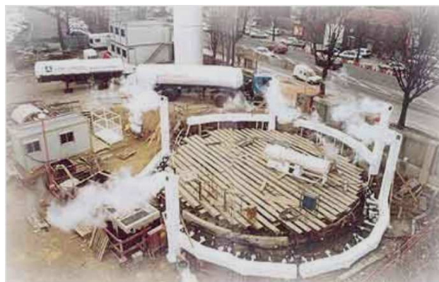
Figure 2.7: Chantier utilisant la congélation du sol.
