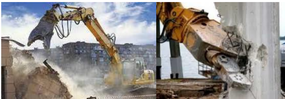
Figure (II. 11) Démolition à l'aide d'une tenaille
