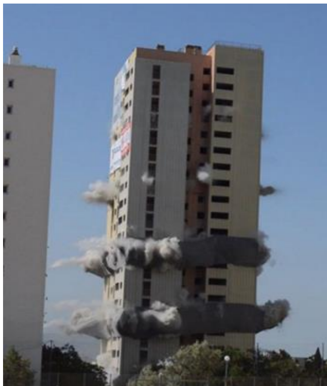
Figure (II. 12) Démolition par dynamitage
