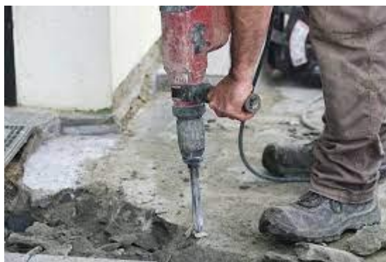
Figure (II. 13) démolition manuelle
