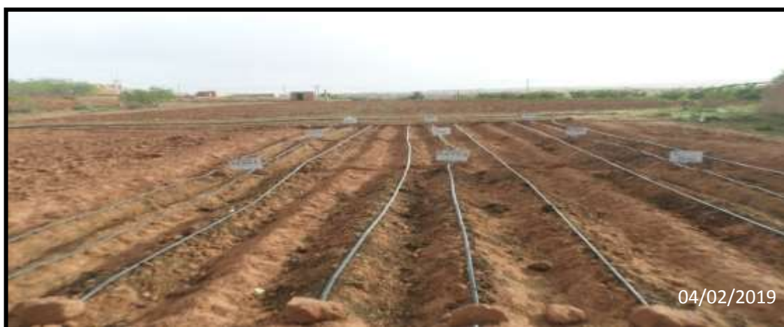
Fig.27:Installation du système goutte à goutte (Original)
