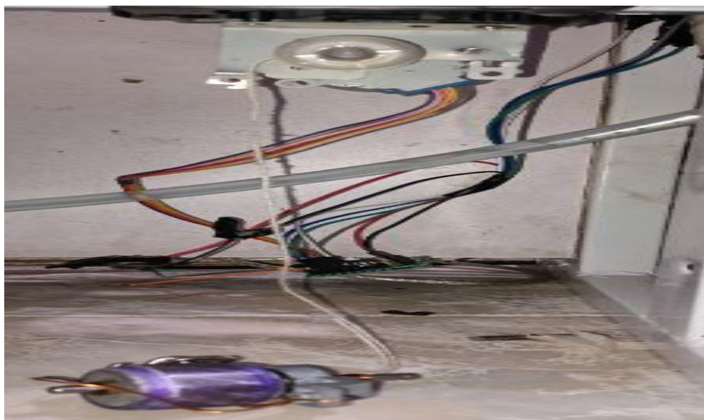
Figure V.93 surveillance de vibration, humidité, température et niveau d'eau
