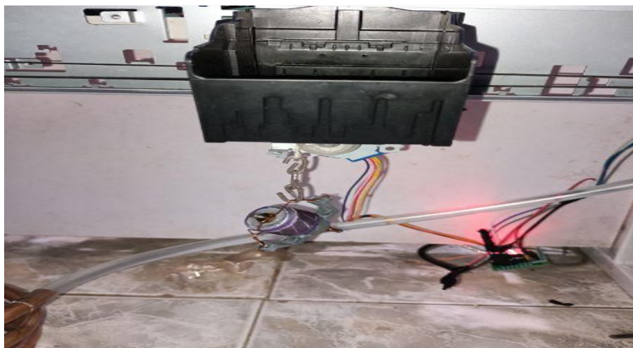
Figure V.82 Porter automatique de la charge vers le four par la gru
