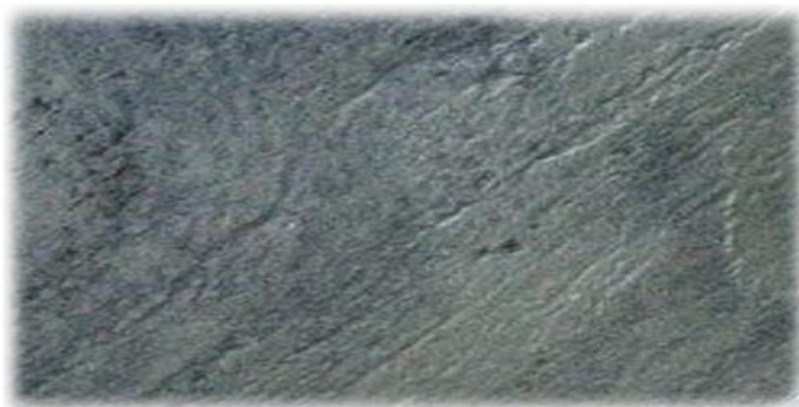
Figure I.23 : Défaut de queue de rat
