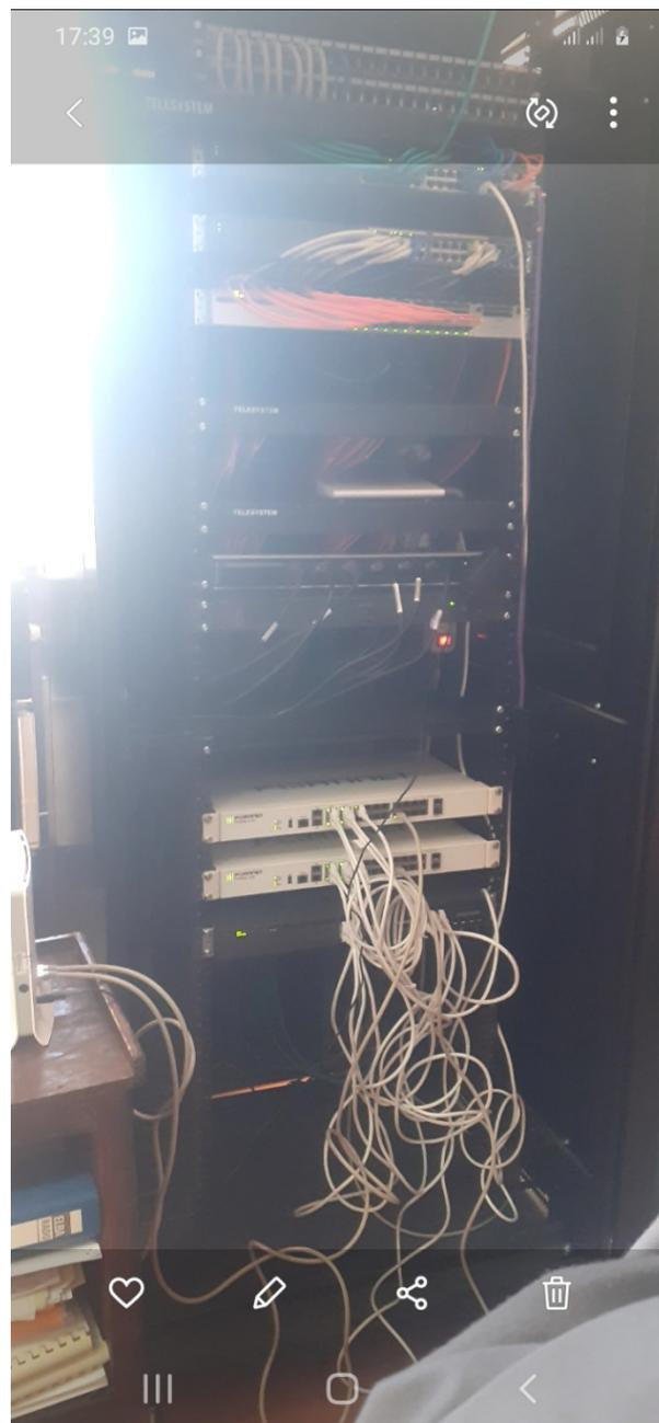
**Figure 3.5-Les départs des lignes vers les ordinateurs de maintenance et de la production et les autres directions[10]**
