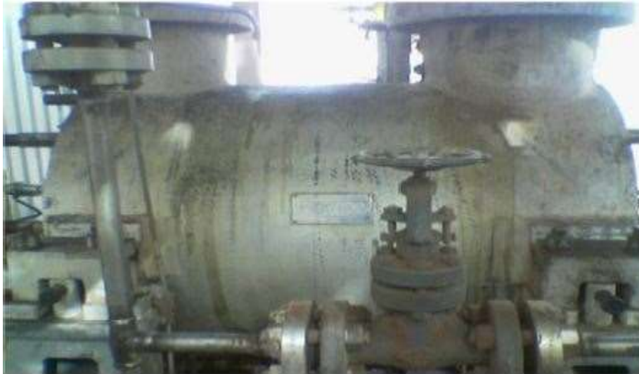
Figure 3.4 : Compresseur centrifuge BCL 406. [28]
