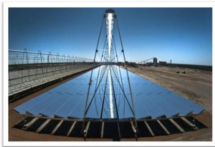
Figure I-5 : Centrales solaires à miroirs de Fresnel [10]
