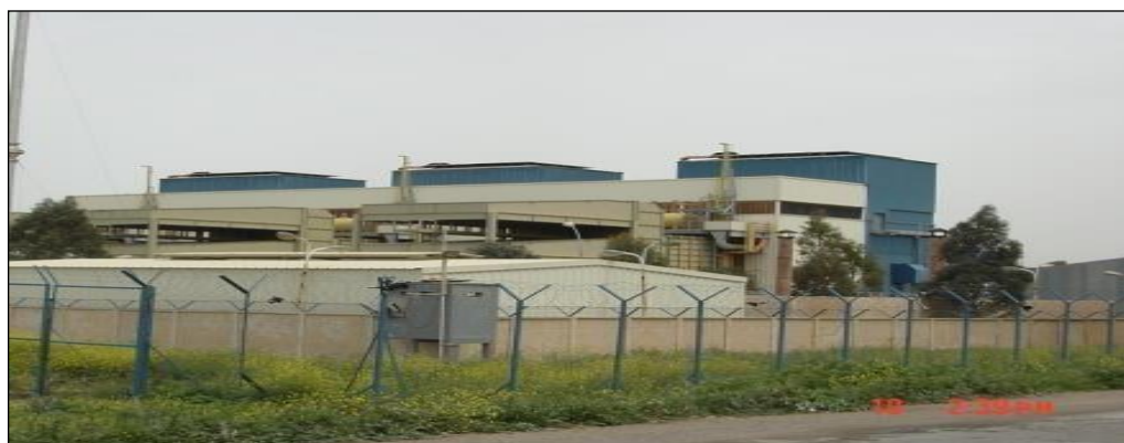
Figure II.1 : Photo panoramique de la centrale.
