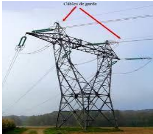
Figure III.7 : Câbles de garde
