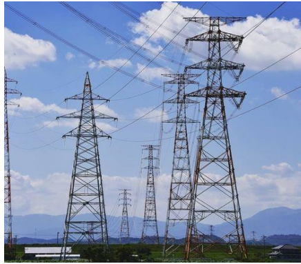
Figure III.16 : Pylône double drapeaux
