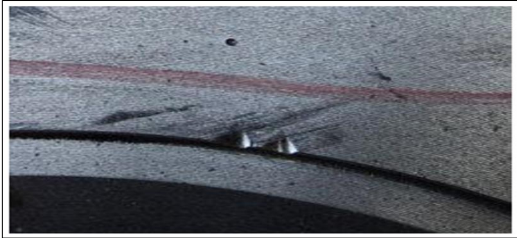
Fig. II-16 : Défaut de dommage mécanique
