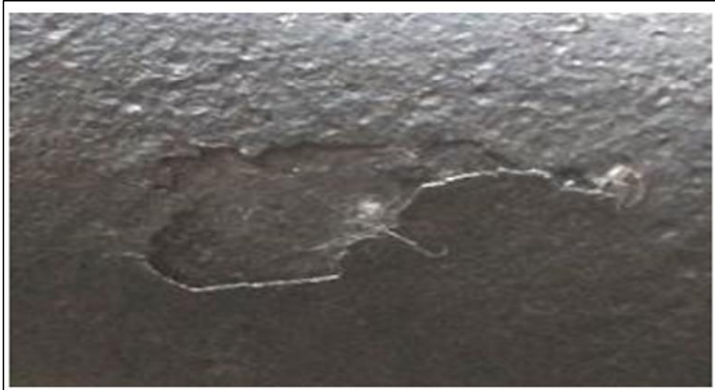
Fig. II-29 : Défaut d'écaillage
