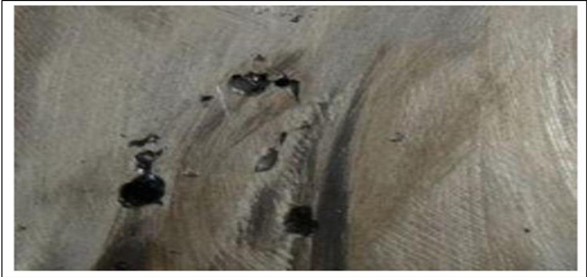
Fig. II-4 : Défaut d'inclusion de sable
