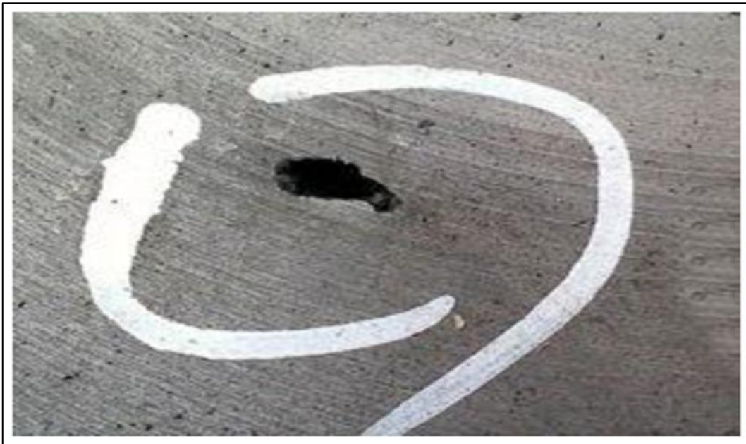
Fig. II-5 : Défaut du trou de sable
