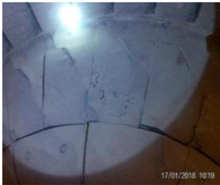
**Fig. II-18 :** Fissuration du blindage du fond d'entrée
