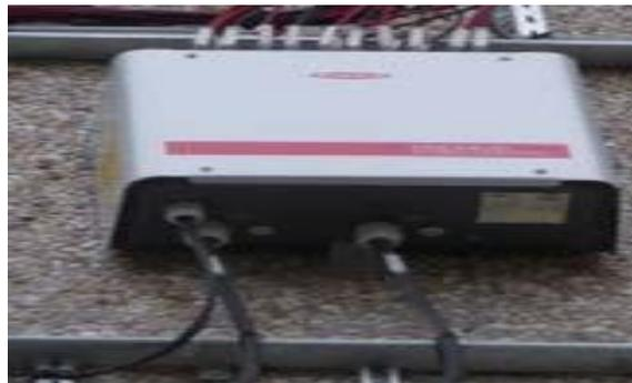
**Figure IV.13** : Inspection visuelle de Boîtes de jonction [48].
