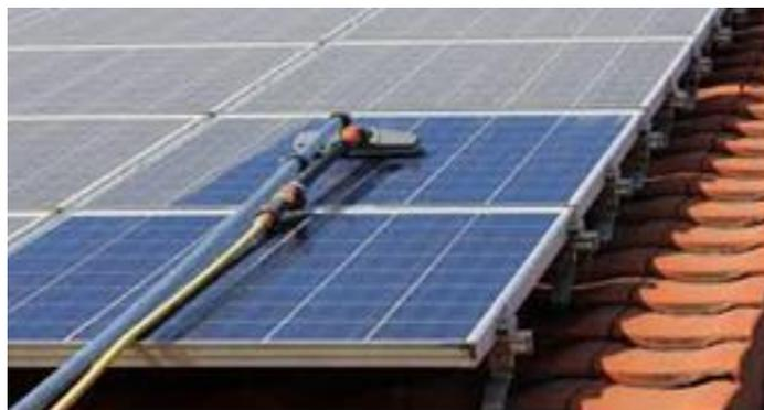
**Figure IV.15** : Nettoyage de modules [48].
