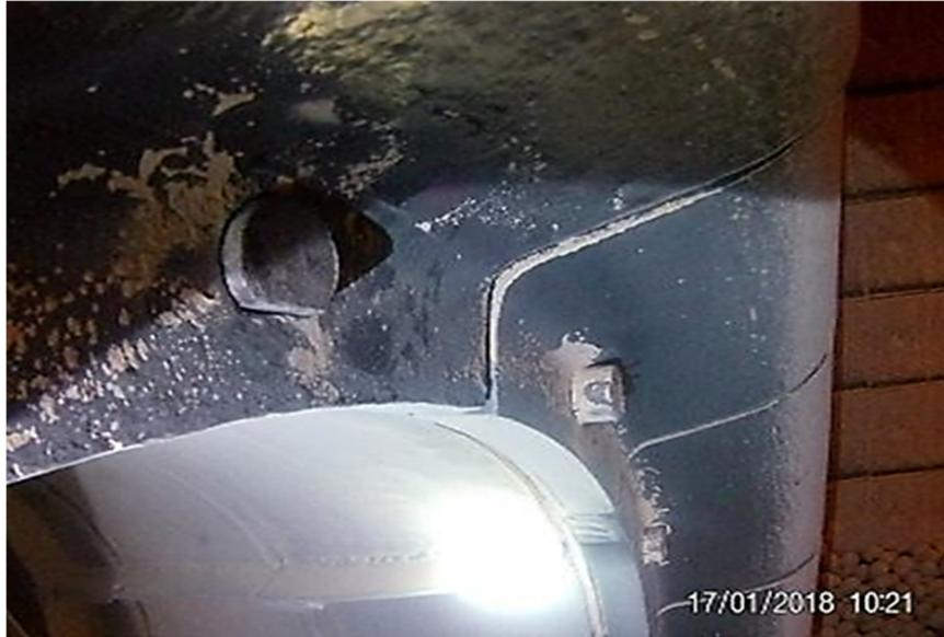
**Figure I.28 :** Desserrage des plaques du blindage de fond d'entrée
