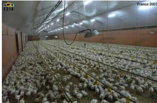
Figure 09 : chauffage au gaz
