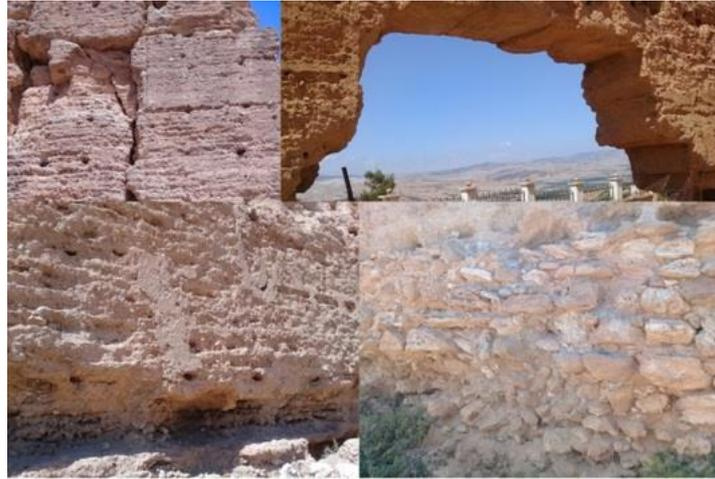
**Image 38.** Sour, Mostaganem. La muraille almohade. Fissures, effondrement, écroulement, anfractuosités et éboulement. Janvier 2020. Crédit photos : Auteure.
