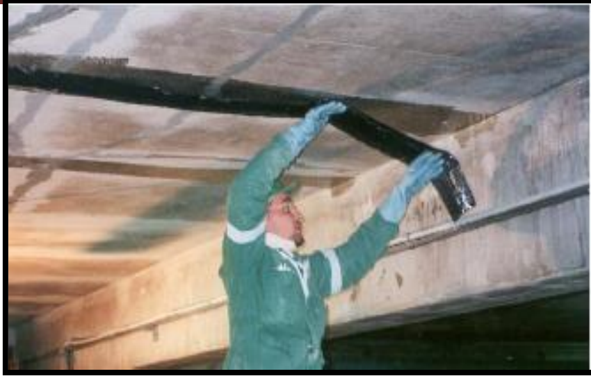
Figure I. 11. Mise en œuvre d'une réparation par stratification
