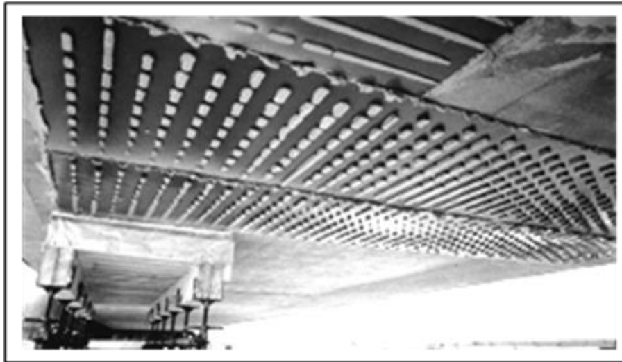
Figure I.8. Renforcement d'un viaduc par tôles collées
