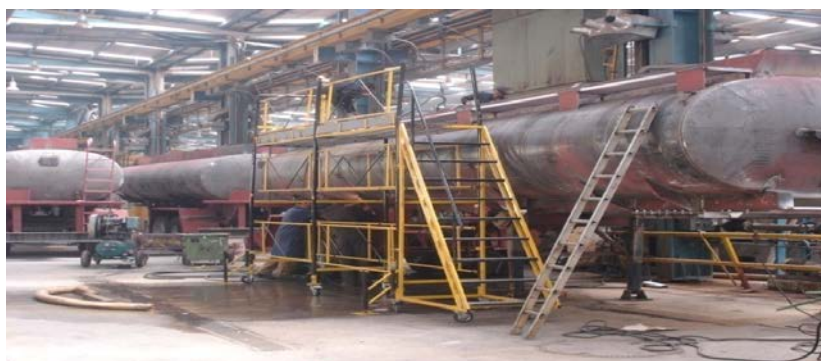
Figure I.15 Image vérification de l'étanchéité d'une citerne.
