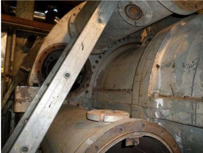
Figure 5.21 : Démontage des chambres de combustion.
