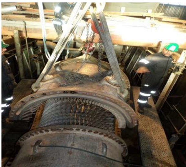
Figure 5.23 : Démontage de la caisse de compresseur et la caisse turbine.
