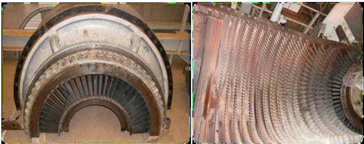
Figure 5.27 : Inspection de la partie supérieure des IGV et les aubes statoriques.
