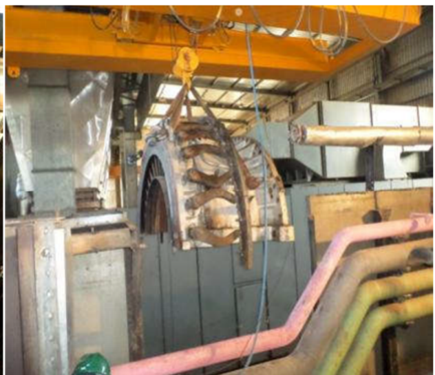
Figure 5.23 : Démontage de la caisse de compresseur et la caisse turbine.
