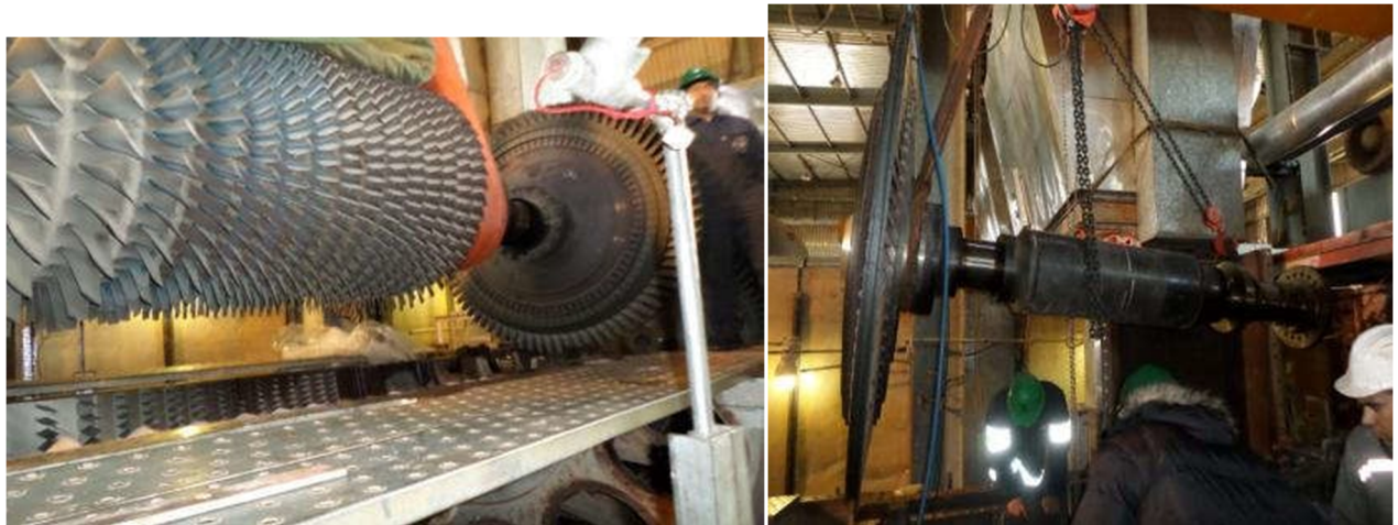
Figure 5.24 : Démontage des rotors HP et BP.
