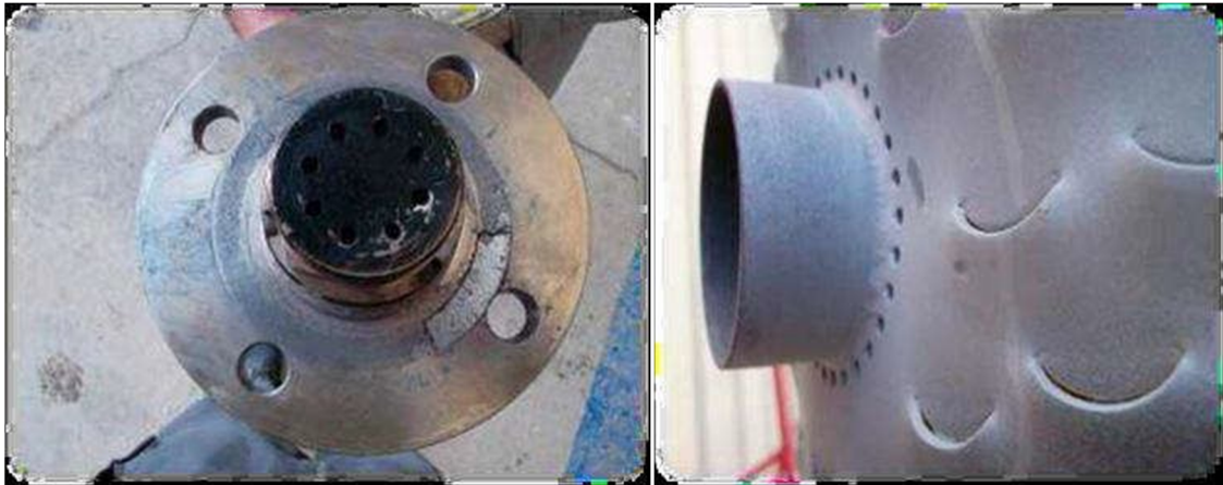
Figure 5.28 : Inspection des injecteurs de combustible et des tubes à flamme.
