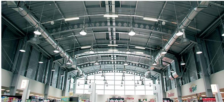
**Figure III.8 :** Poutres alvéolaires contre fléchées de 25 mètres
