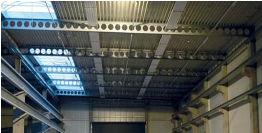
**Figure III.4:** Poutre de toiture ACB®
