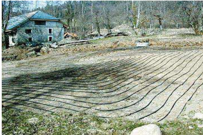
Figure I.25 : Pompe à chaleur système captage horizontal
