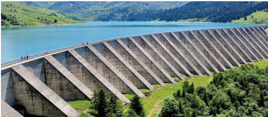
Figure I.13 : Barrage à contrefort
