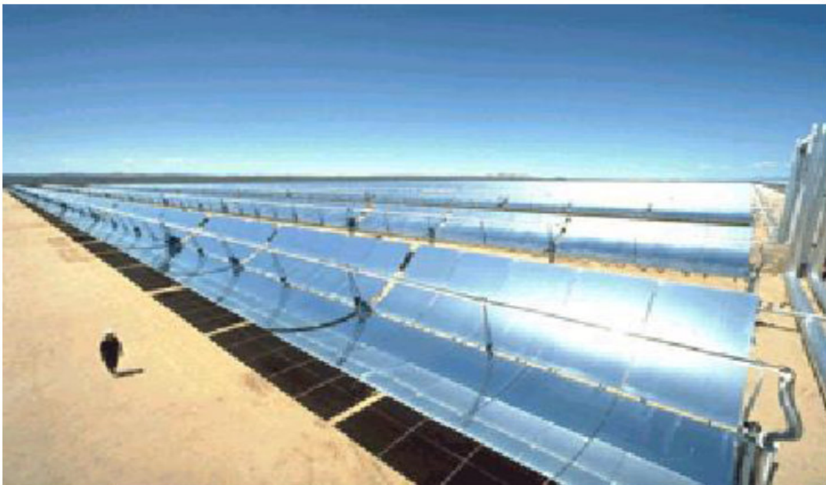
Figure 2.1 : Champ de miroir cylindro-parabolique à la centrale solaire de Kramer Junction en Californie.
