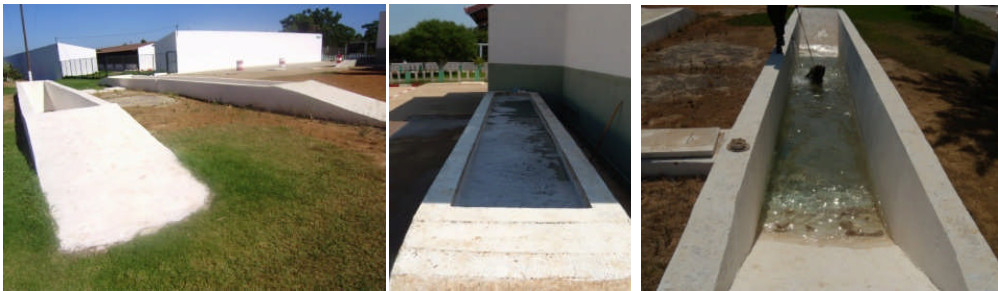
Photo N°8 : bains de déparasitage
