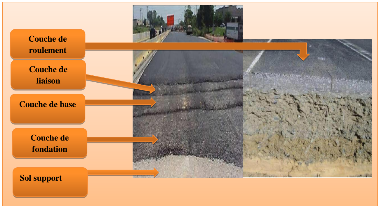
Figure IX- 6: les différentes couches d'une chaussée.
