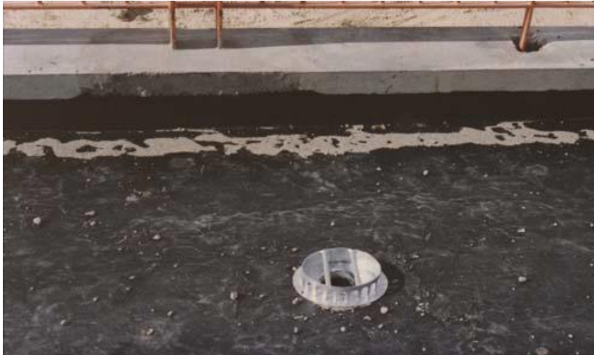
Image VII- 5 : Equipements sur le pont (Evacuation des eaux, étanchéité, corniche).
