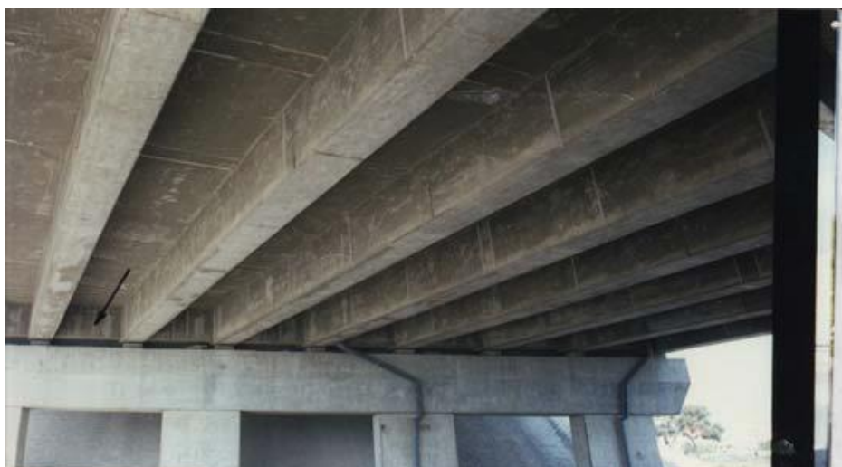
Image VII- 4: Tablier d'un pont à poutre.
