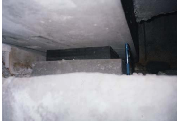
Image VII- 7: Appareil d'appui sous une poutre.
