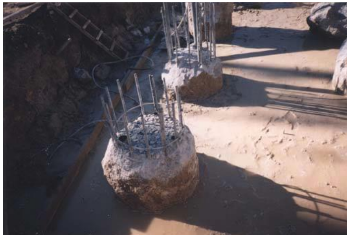
Image VII- 1: Tête des pieux en cours de recépage.
