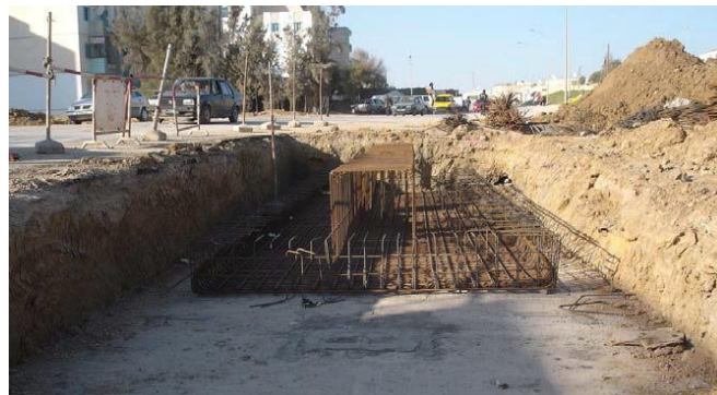
Image VII- 2: Fondations superficielles du pont.
