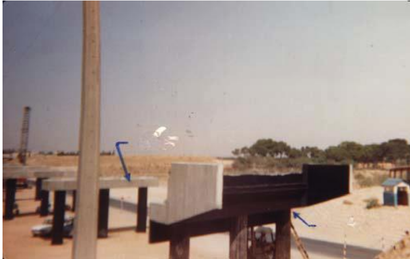
Image VII- 3: Appuis du pont (culée et piles).
