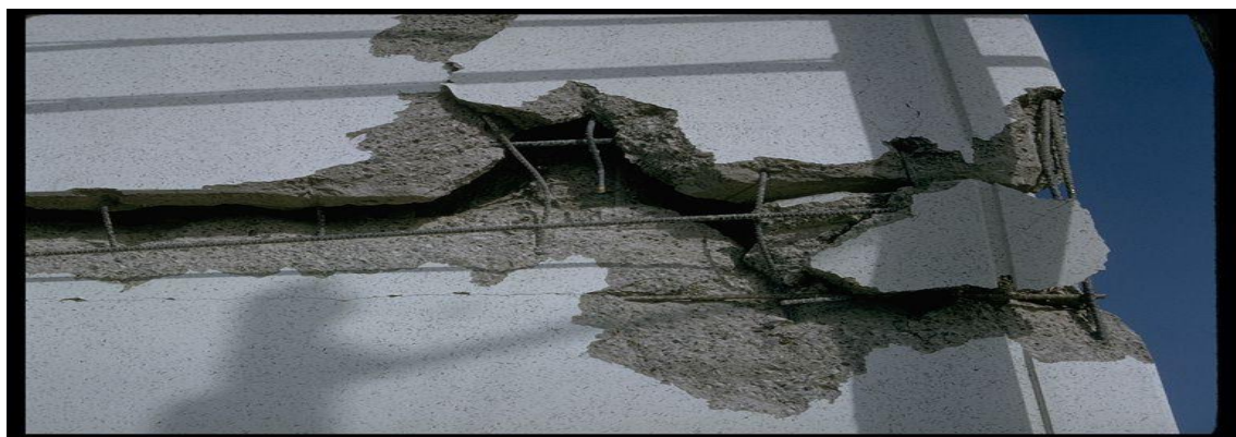
Figure I-10 : Cisaillement d'un voile faiblement armé (Séisme d'Anchorage,1964) (Document Karl – V Steinbrugge).
