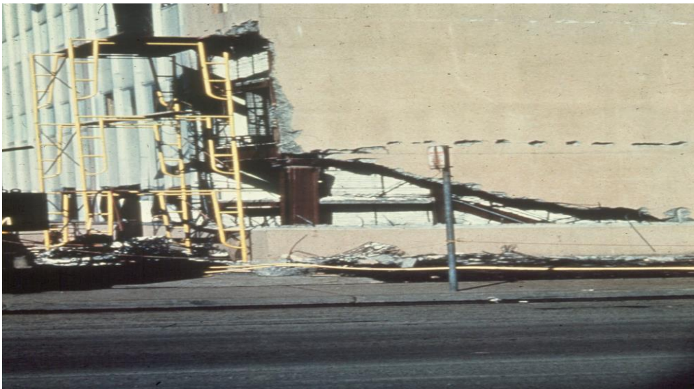
Figure I-11 : Cisaillement de la zone critique d'un voile (séisme d'Anchorage, 1964).
