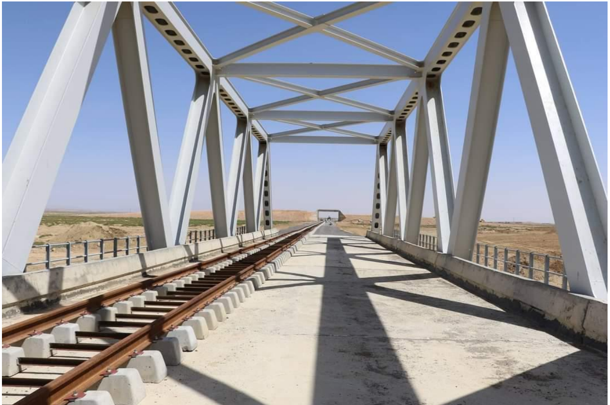
Figure VII.1 : Pont rail d'une voie unique
