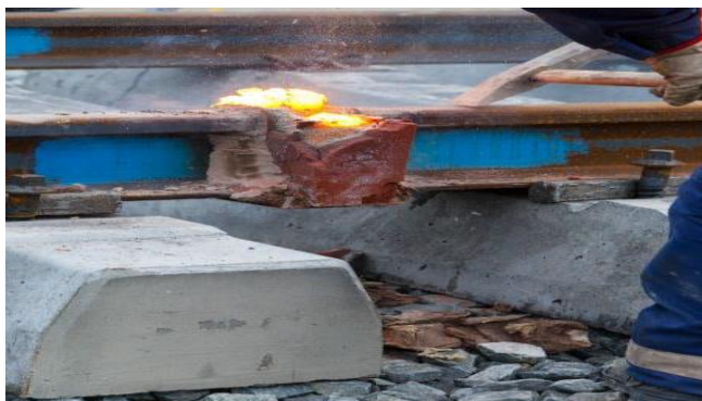
Figure VI.10 : Tranchage du rail
