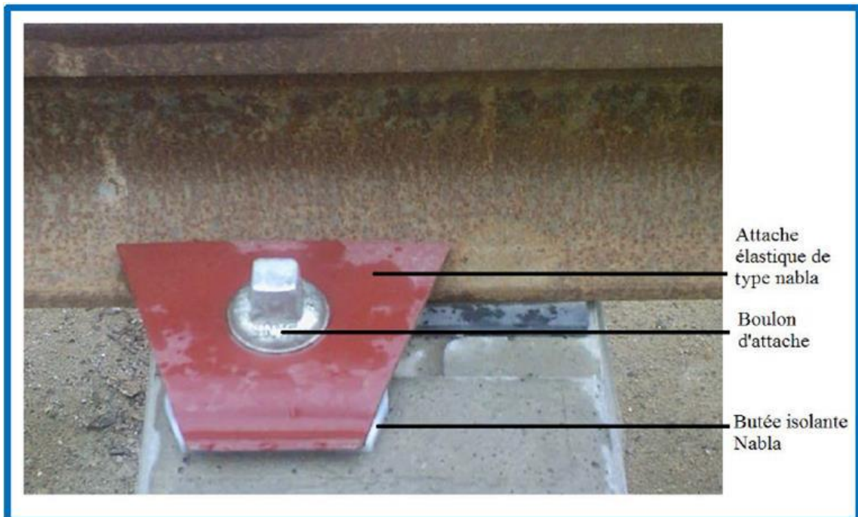
Figure VI.18 : Les éléments d'une attache de type Nabla
