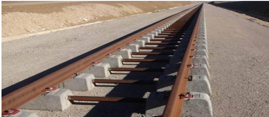
Figure VI.13 : Travers en Bi bloc
