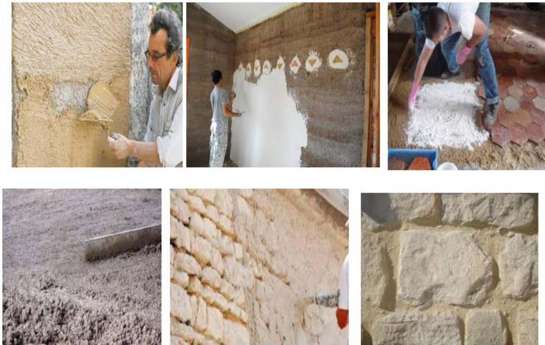
Figure. II. 12 : Différentes utilisations de la chaux dans le bâtiment
