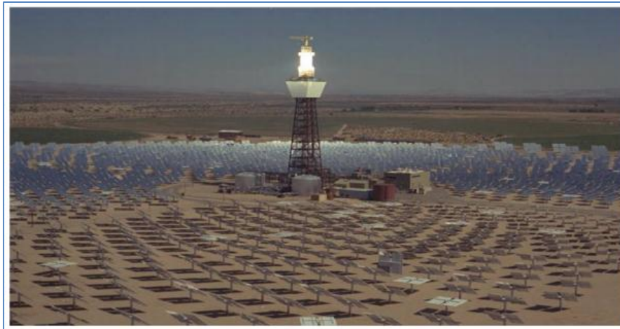
Figure I-18 : Centrales solaires à tour.
