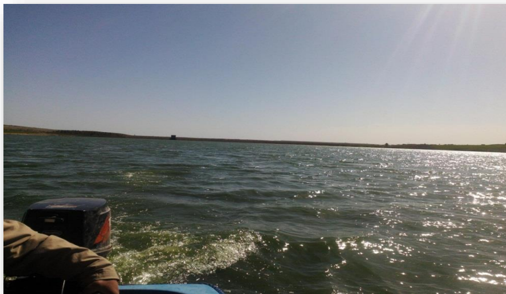
Fig.2 : photo original de Barrage Colonel de Bougara (2017)
