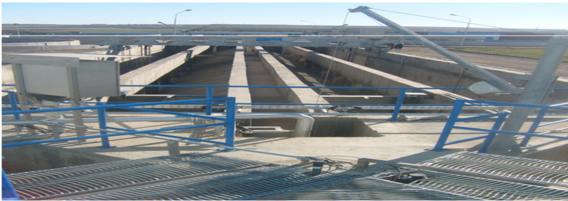
Photo IV. Bassin de dessablage et déshuilage.
