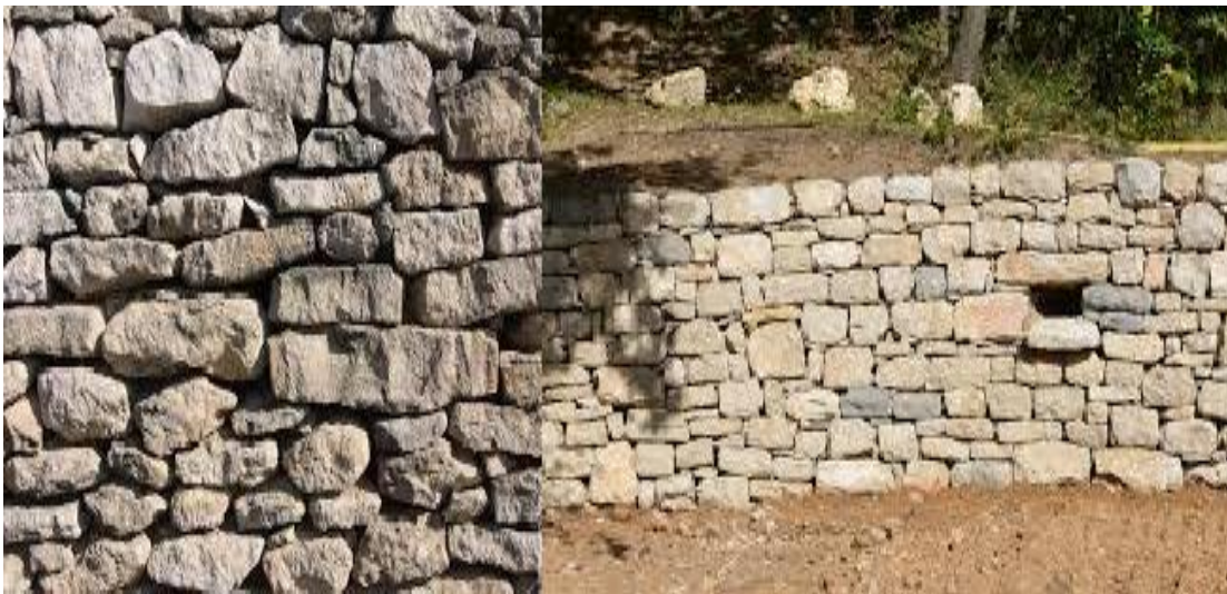
Figure II.6 Mur en pierres sèches
