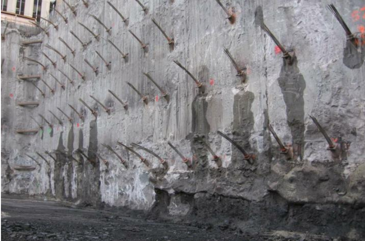
Figure II.14 Les parois moulées avec des tiges d'ancrages
