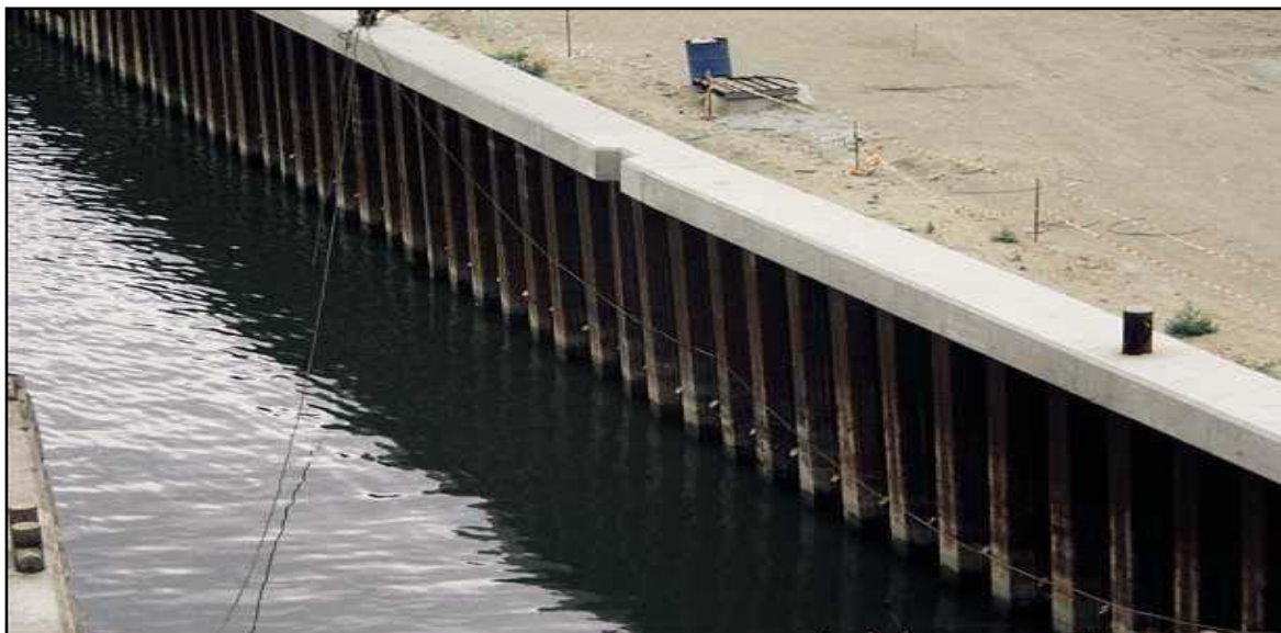
Figure II.13 Les rideaux de palplanches
