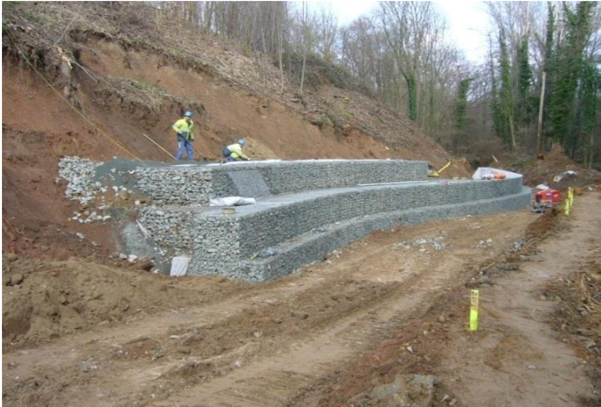
Figure II.5 Chantier en cours de réalisation utilisant le technique gabion
