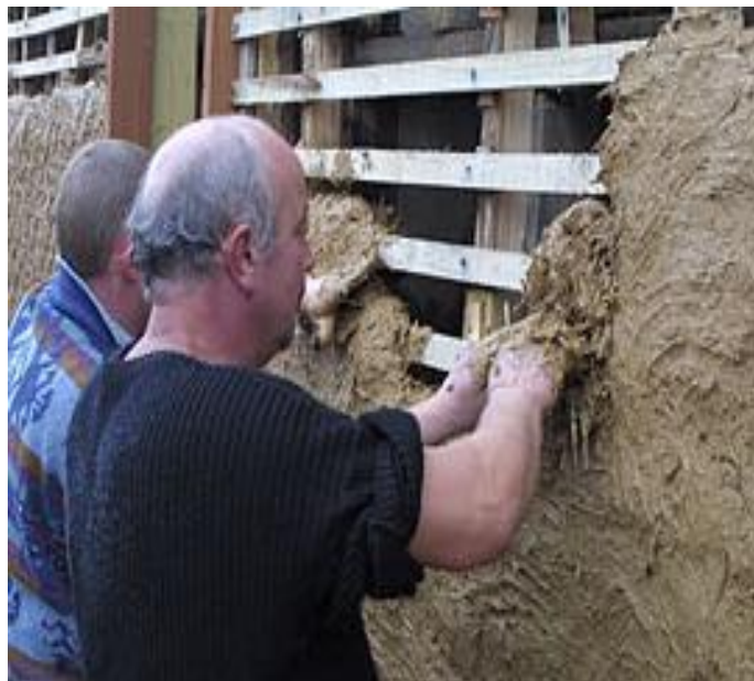
Figure 10 : Mise en place du torchis.
