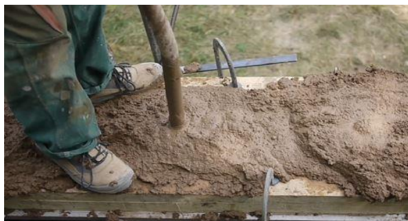
Figure 18: La terre coulée, un béton de terre.
