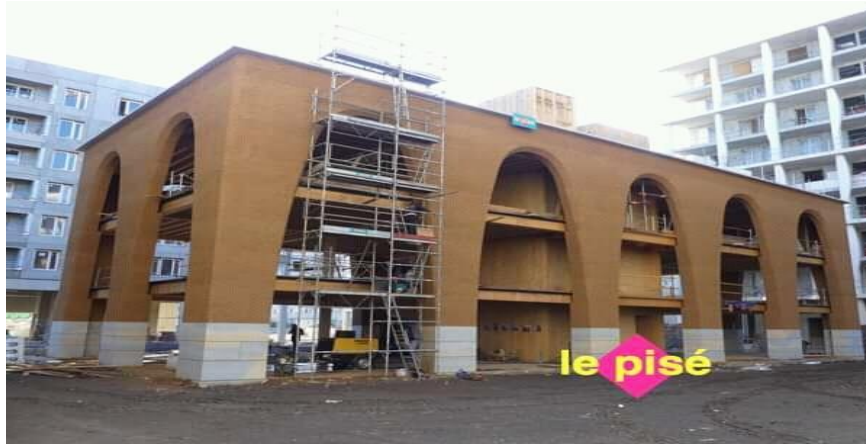
Figure 9: Construction en pisé.
