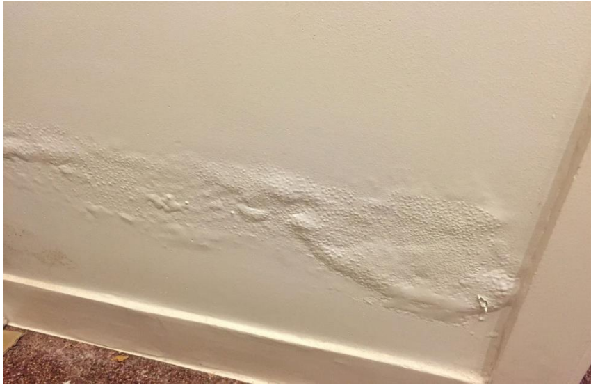
Figure 24 : les remontées capillaires.
