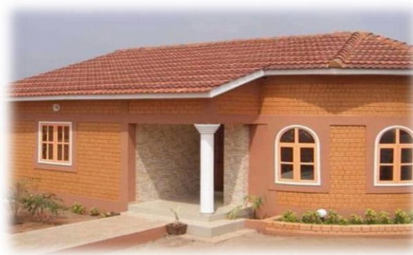
Figure 13: Construction en BTC.
