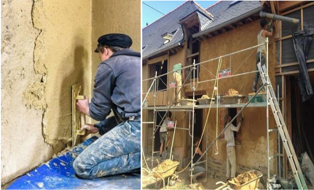
Figure 14: Application d'un enduit terre.
