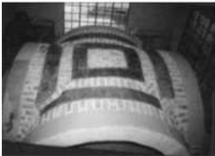
Figure.2.24. Mise en place des lamelles sur une coupole [47]
