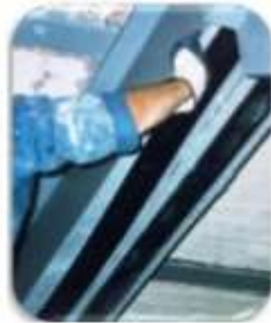
Figure.2.19. Mise en place des lamelles sur une poutre [47].
