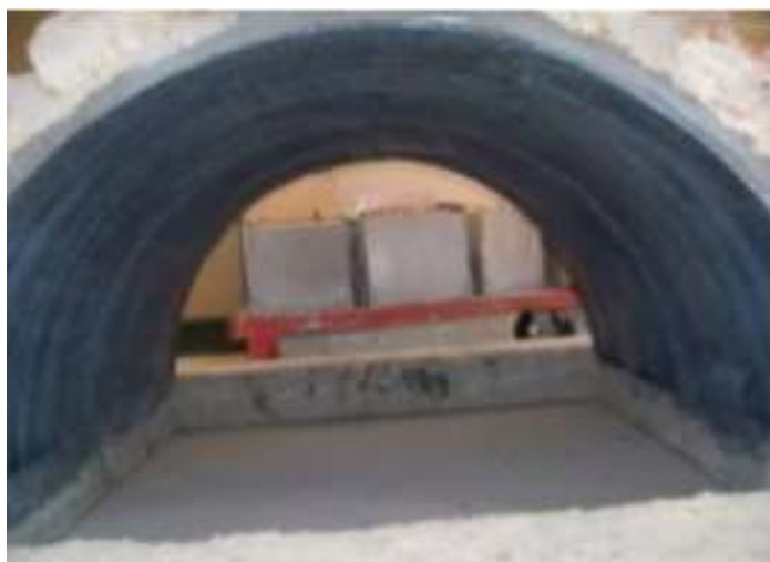
Figure.2.25. Mise en place des tissus de carbone sur des voûtes [47]
