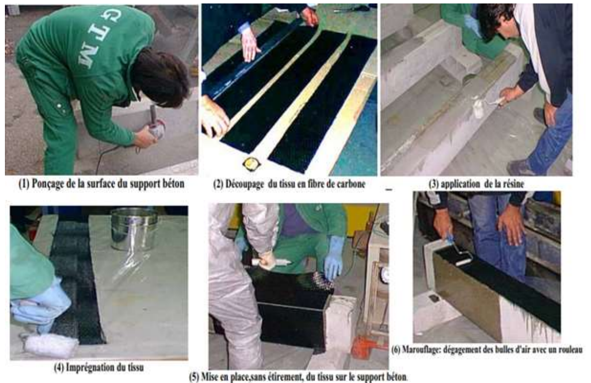
Figure.2.13. Procédé de mise en œuvre des matériaux composites [12, 43].
