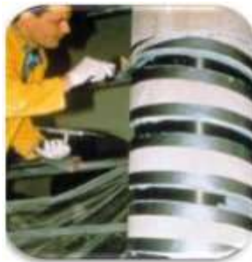
Fig.2.21. Mise en place de lamelles de carbone autour d'un poteau [47]
