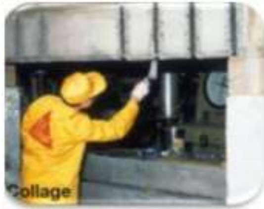
Figure.2.20. Mise en place d'équerres de renforcement sur une poutre en T [47]-
