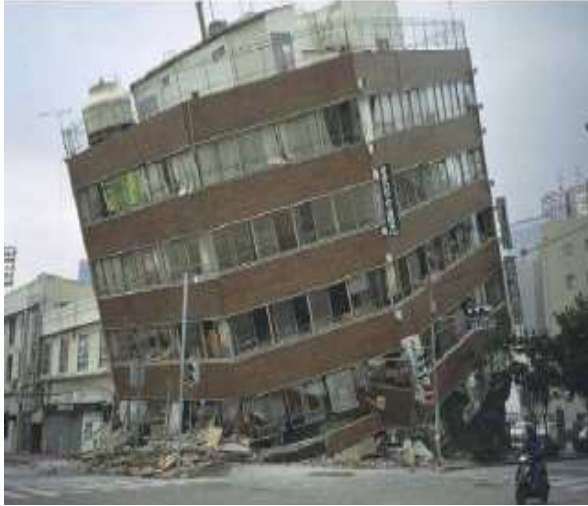
(a). Effondrement de l'étage inférieur (Kobe, 1995).
