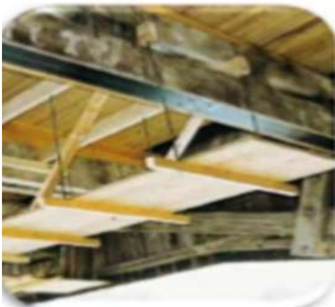
Figure. 2.23. Mise en place des lamelles sur une structure bois [47]
