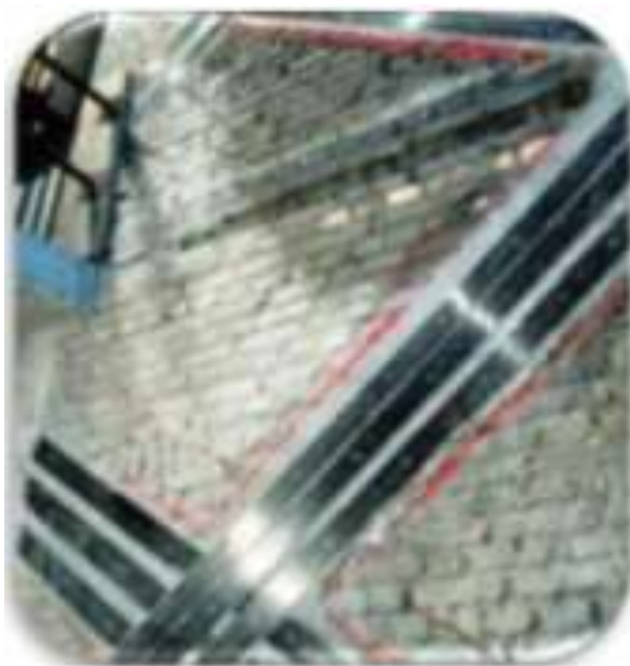
Figure.2.22. Mise en place des lamelles sur un mur en briques [47]
