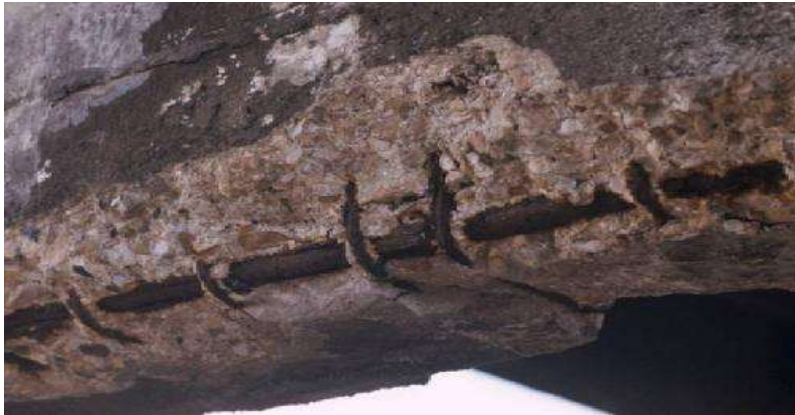
(a) Pont à poutre
