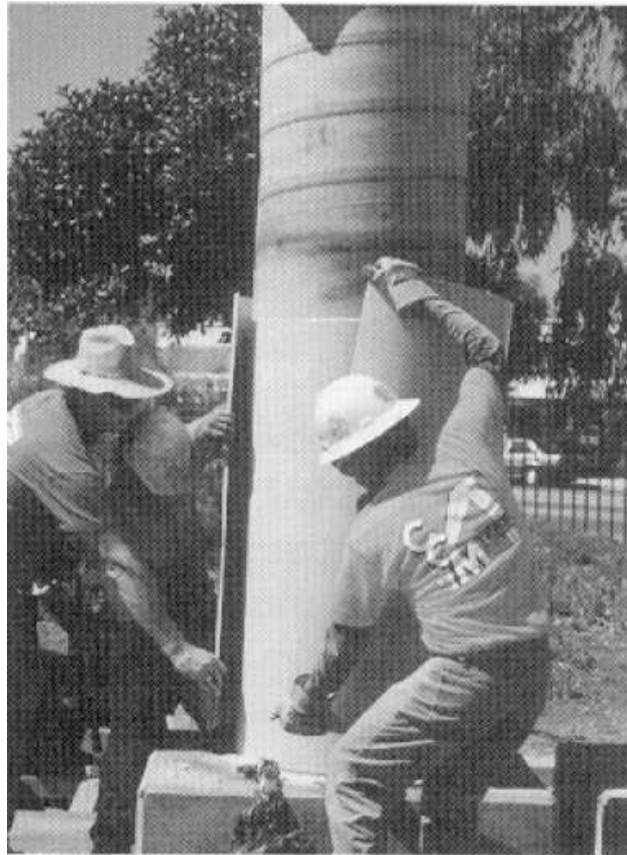
Figure.2.18. Chemisage par coquille préfabriquée en «PRF» (Monti 2003) [33].
