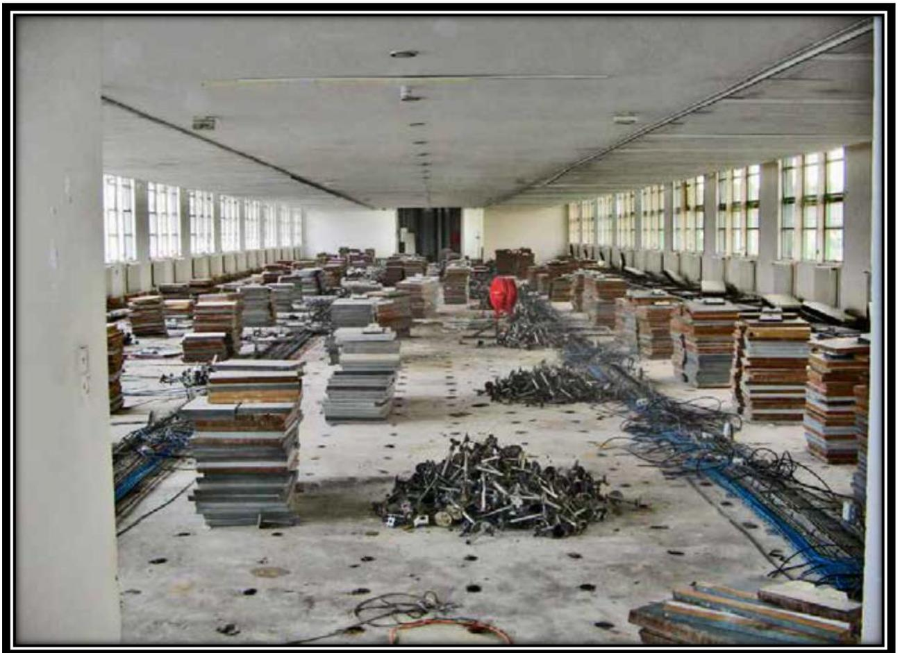
Figure (1.7): Tri durant une déconstruction sélective
