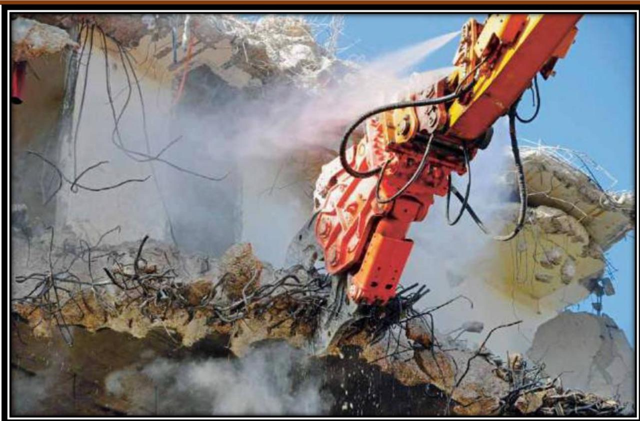
**Figure (I.5):** Démolition à l'aide d'une tenaille
