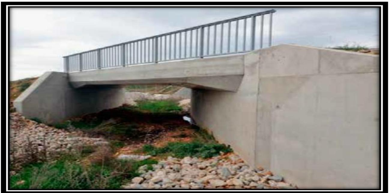
**Figure (I.10) :** Vue du pont construit avec un béton de granulat recyclé après 2,5 ans
