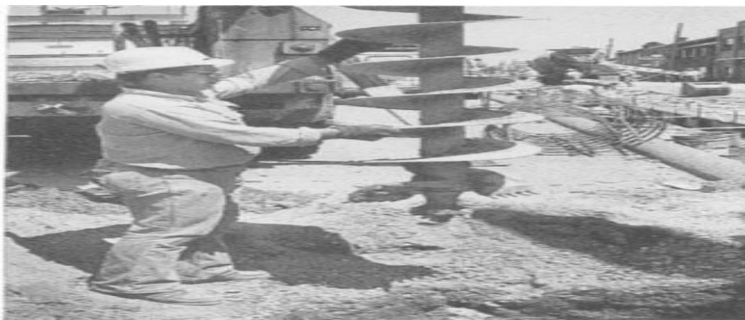
Figure I-17 Tarière verticale avec outils à pointe en carbure utilisée dans les constructions lourdes[37].
