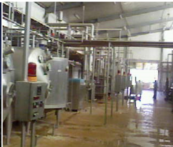
Figure n° 03: L'intérieur de l'unité.
