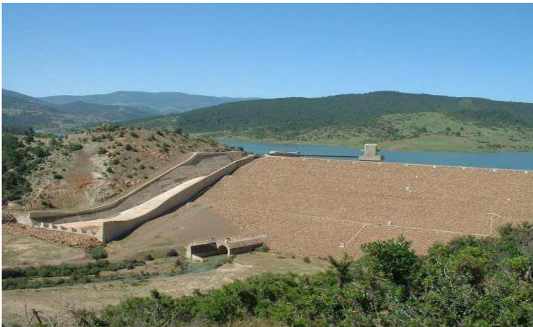
**Figure I.7 :** Barrage en enrochement (barrage Deurdeur / Aïn Defla).
