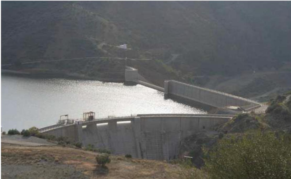
**Figure I.4 :** Barrage-voûte (barrage Tichy Haf / Bejaïa).
