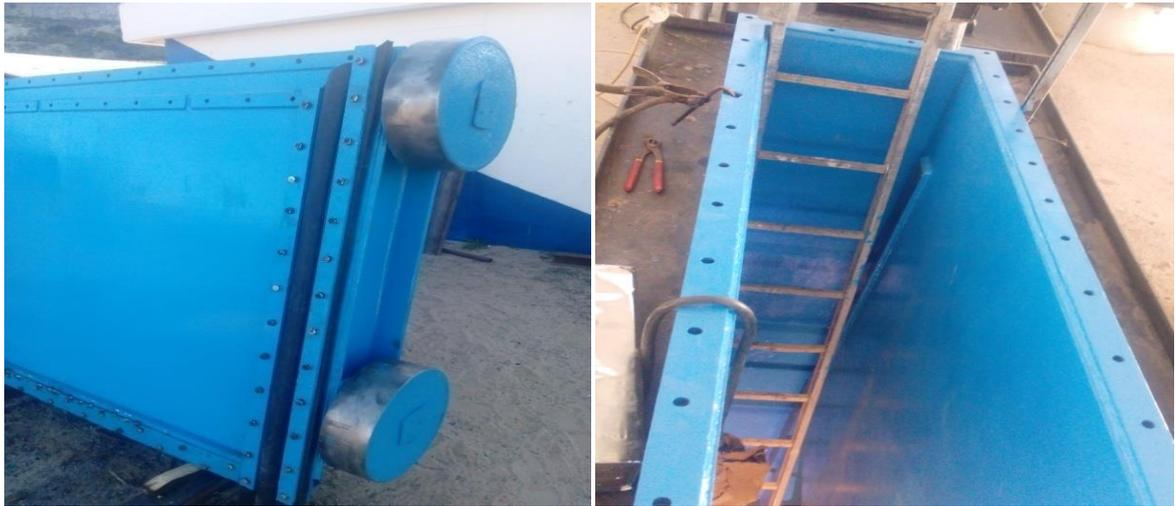
**Figure II.18 :** Préparation du tiroir et mise en place des joints.
