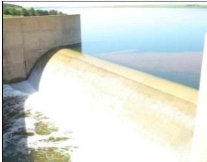
**Figure II.4 :** Evacuateur de crue du barrage de Dahmouni.
