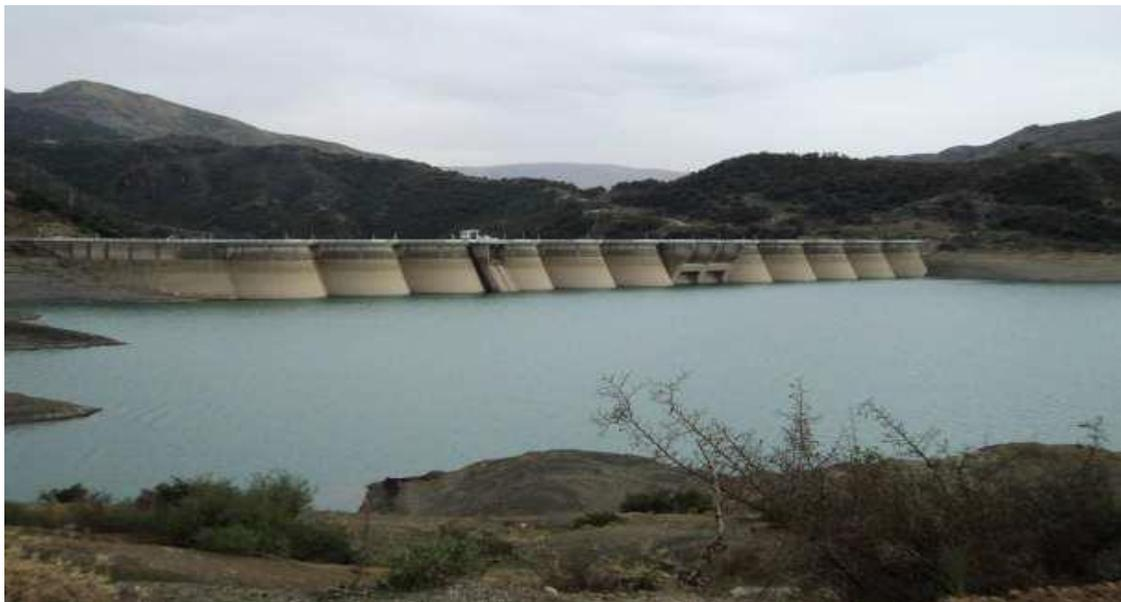
**Figure I.3 :** Barrage à contrefort (barrage Erraguene / Jijel).
