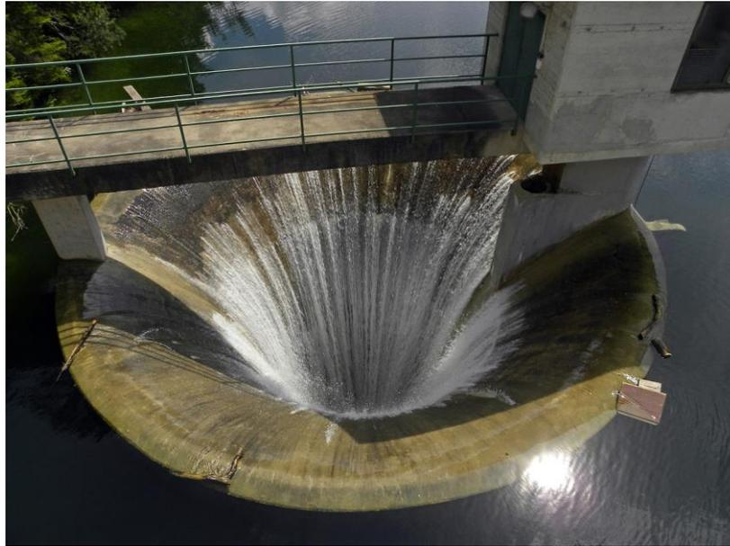
**Figure I.17 :** Déversoir de barrage.
