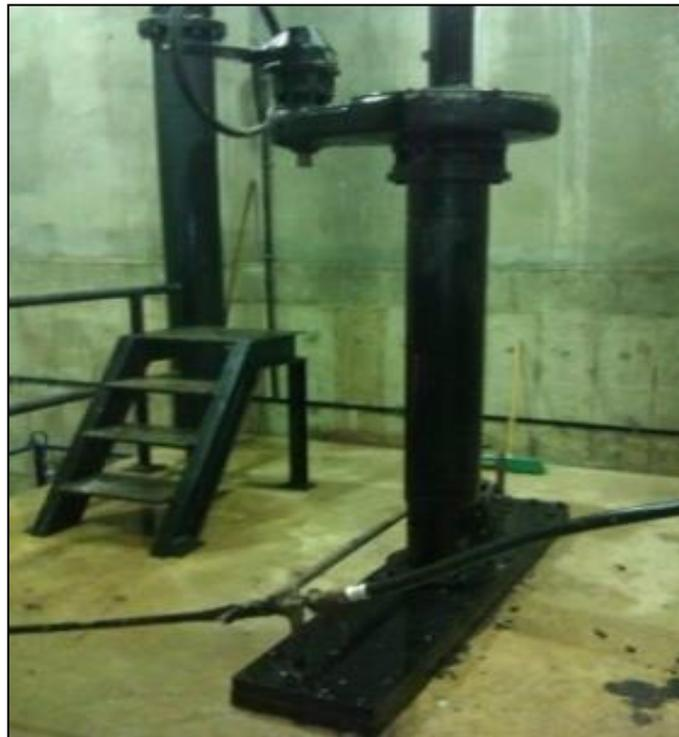
**Figure II.6 :** Vanne pour vidange de fond du barrage de Dahmouni.
