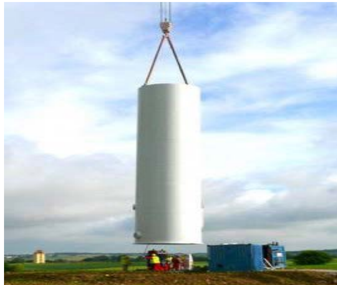
Figure I.13 : Pose de la première section du mât.
