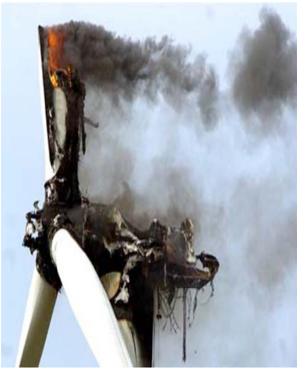
a) Incendie de la nacelle d'une éolienne le 14 janvier 2016 lors de travaux d'entretien
