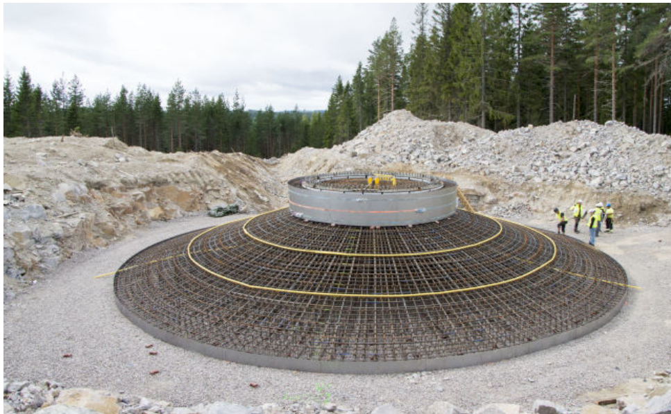
Figure I.15 : Les fondations de grande éolienne. [38]
