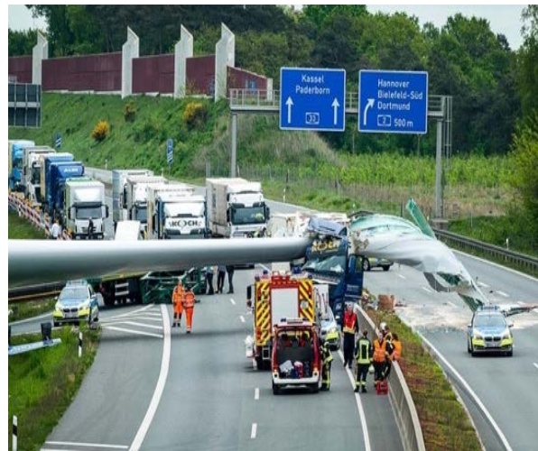
d) Effondrement d'une éolienne sur une autoroute Allemande près de Bielefeld en 2017.
