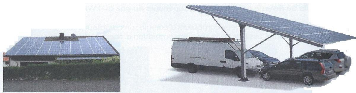
Toit solaire particulier
