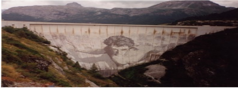
Figure I.12 : Barrage voûte
