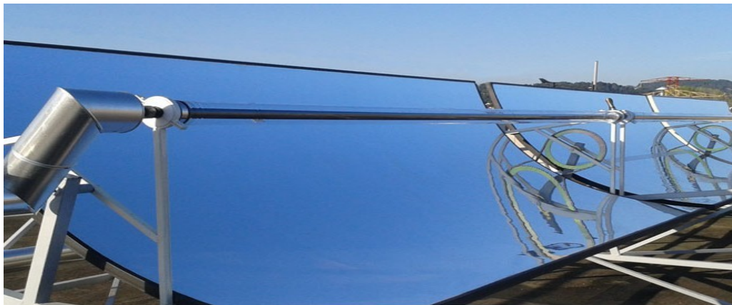
Figure I.07 : Concentrateur solaire cylindro-parabolique
