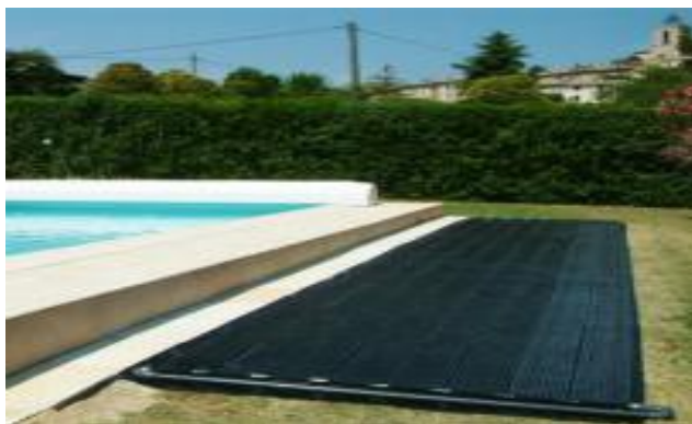
Figure I.04 : Capteur plan sans vitre
