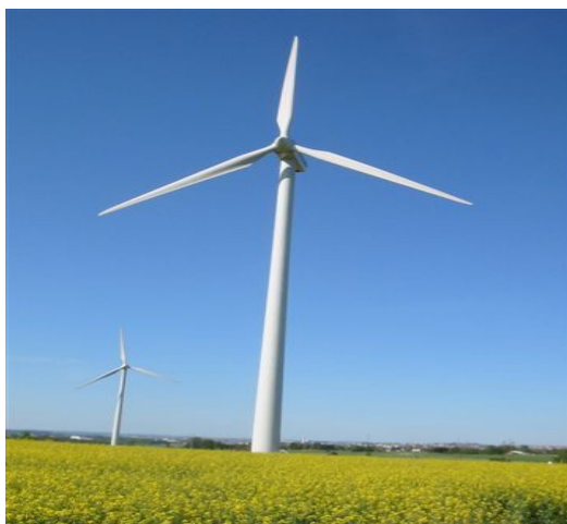
Figure I.16 : Eolienne à axe horizontal
