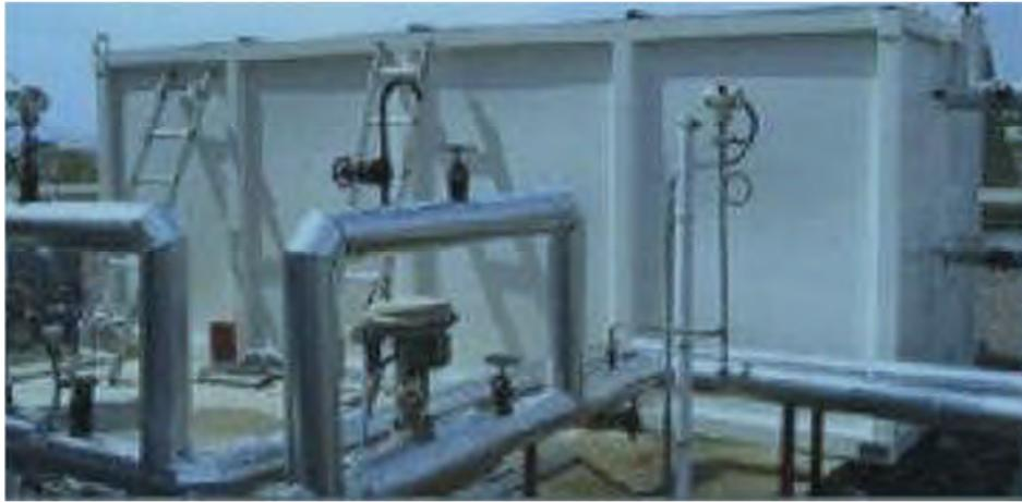
**Figure II.6** accumulateur de chaleur solaire développé.
