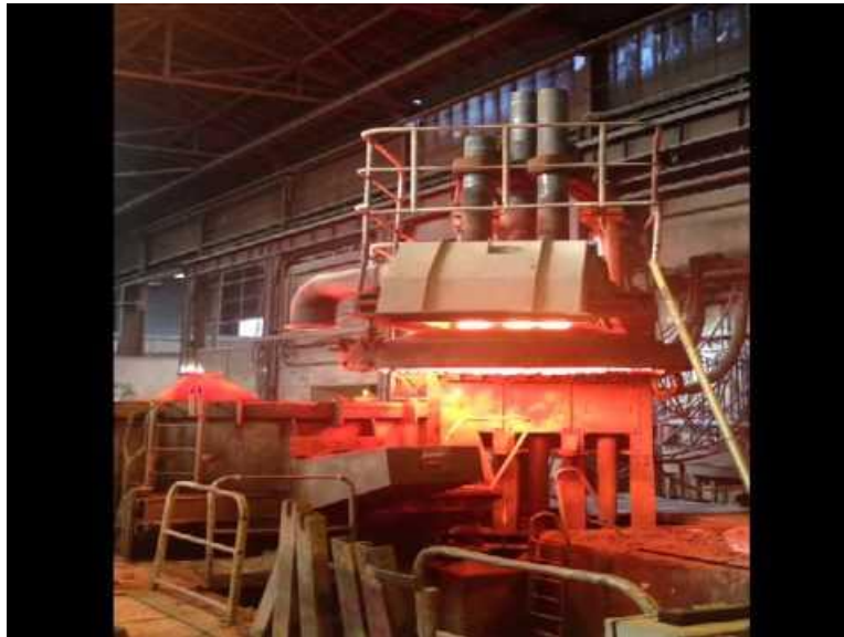
Figure 2.4. Four à arc électrique
