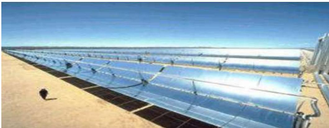
**FIGURE I. 9 : Capteur cylindro-parabolique**
