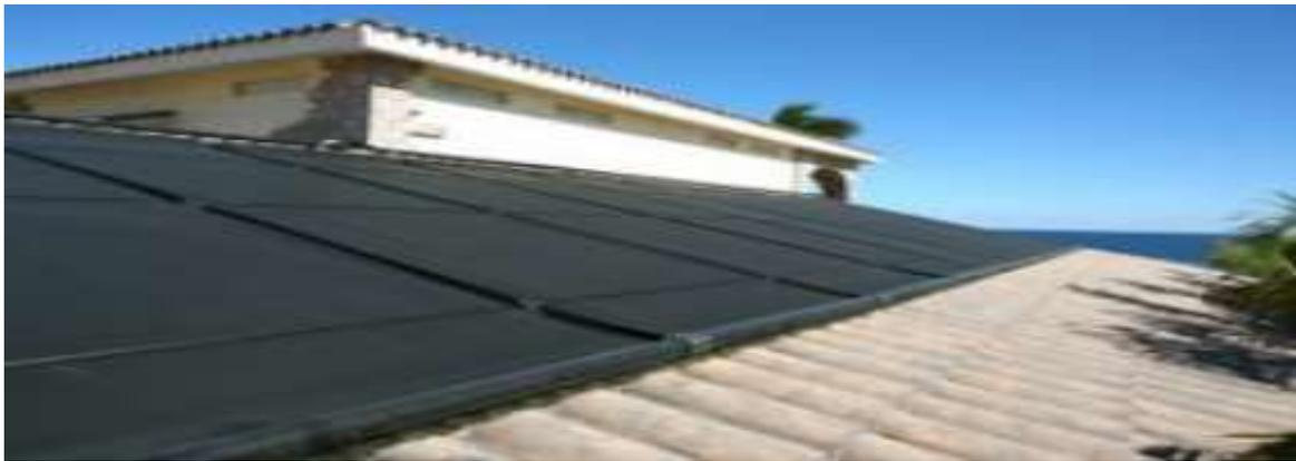
FIGURE I. 4 : Capteurs solaires sans vitrage
