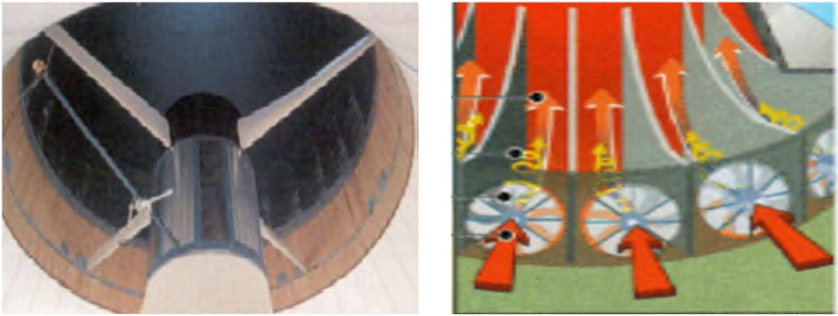
**Fig.II.4 :** Turbines d'une tour solaire.
