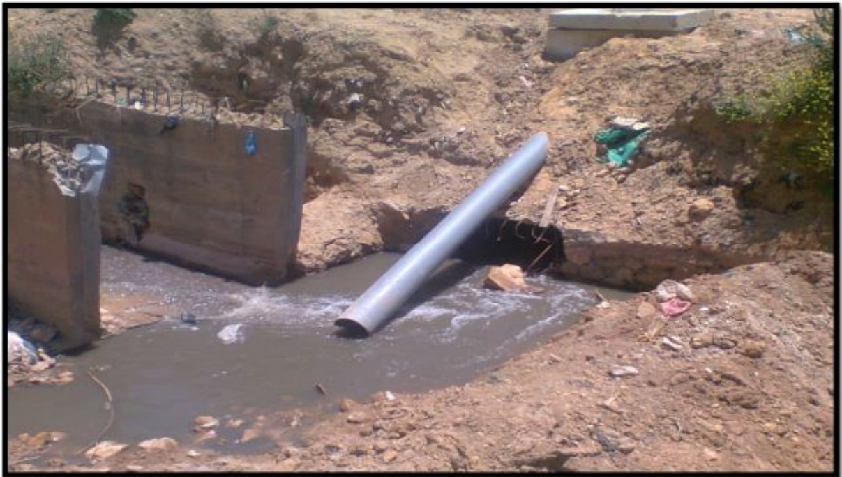
Photo 2 : Exutoire du collecteur de la galerie d'évacuation.
