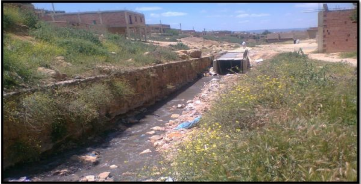
Photo 1 :Rénovation de la Galerie Chaabet Arbia.
