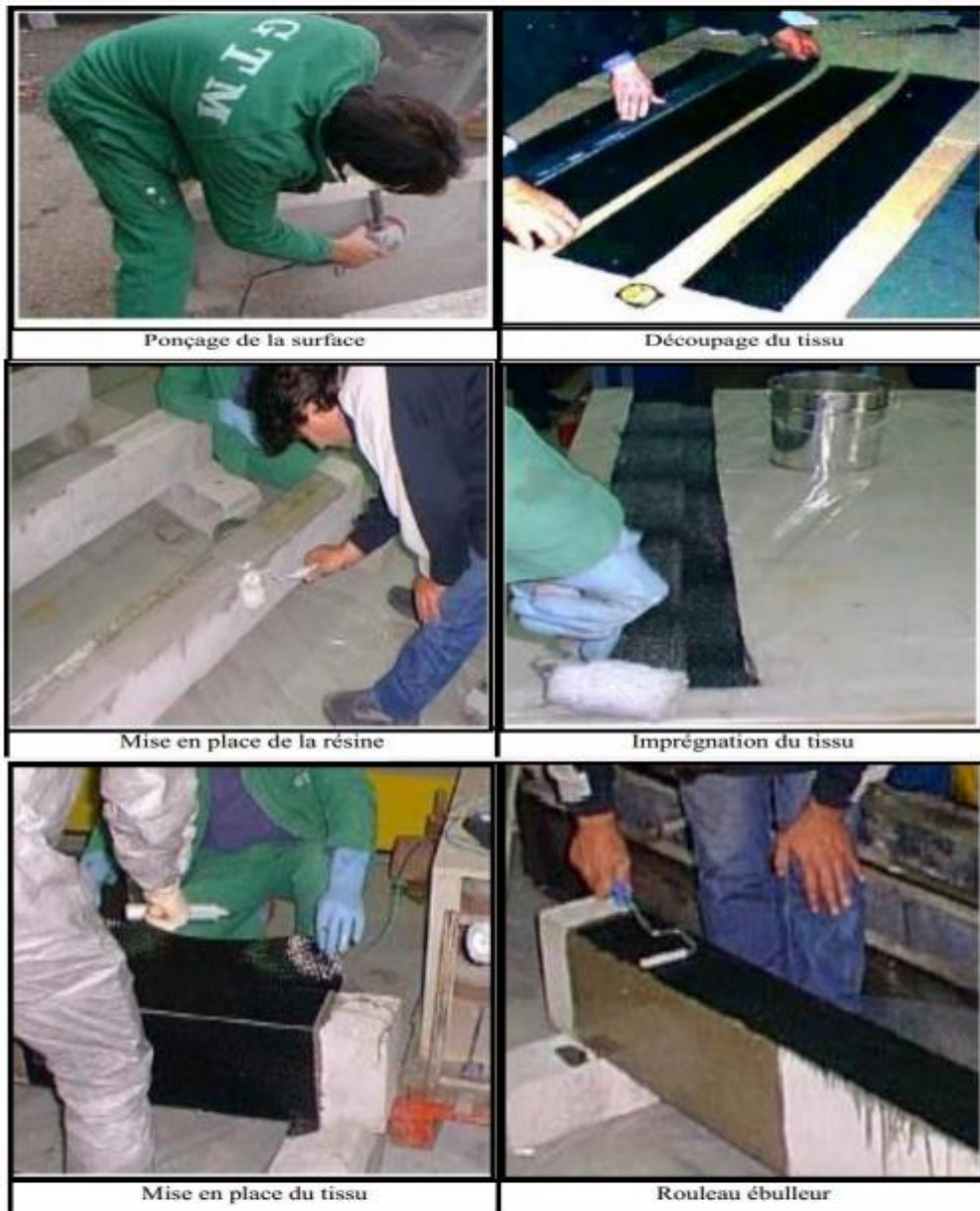
Figure I.20: Mise en œuvre d'une réparation par stratification. [(Boulaziz,A).2014]
