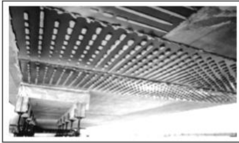
Figure I.15: Renforcement d'un viaduc par tôles collées. [(Boulaziz.A).2014],
