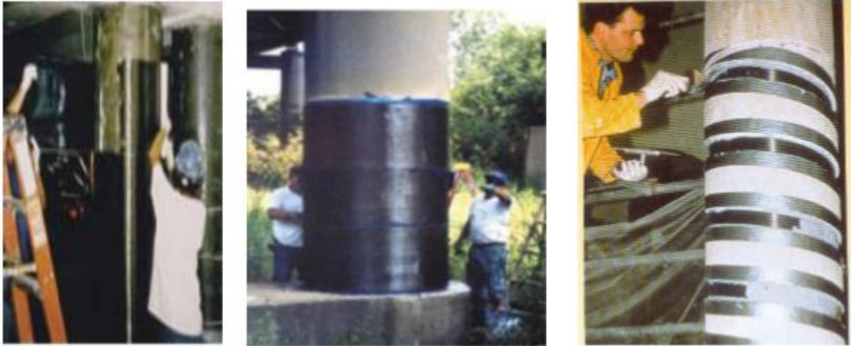
Figure III.11: confinement des poteaux par stratification directe [(WBAC).2003]
