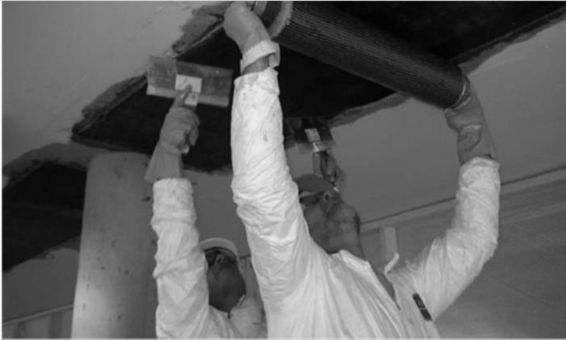
Figure I.21: Mise en œuvre d'une réparation par matériaux composites. [(Amjad kreit).2012]
