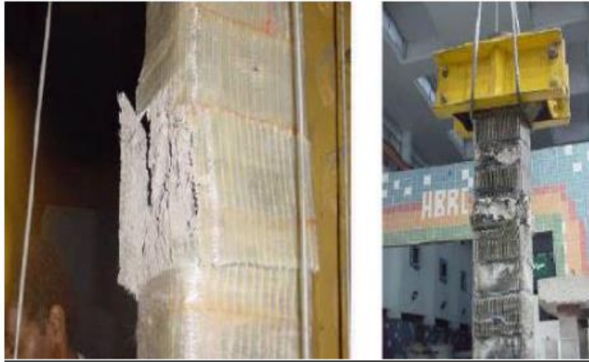
Figure I.19: confinements d'un poteau au moyen de CFRP. [(Belhannachi H).2009]
