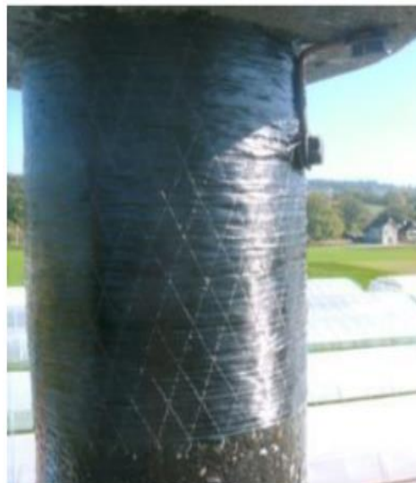
Figure I.18: Poteau circulaire en BA confiné par matériaux composites. [(NEZAR RAMZI).2018]
