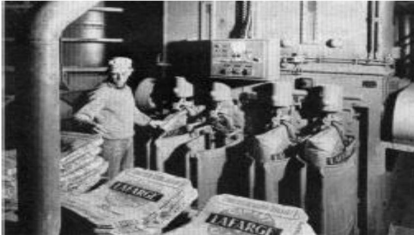
**Figure I-7:** Remplissage les sacs de ciment [18].
