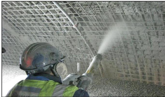
*Figure II.6 : Une projection de béton à une surface. [(ECOBATIS), 2018]*
