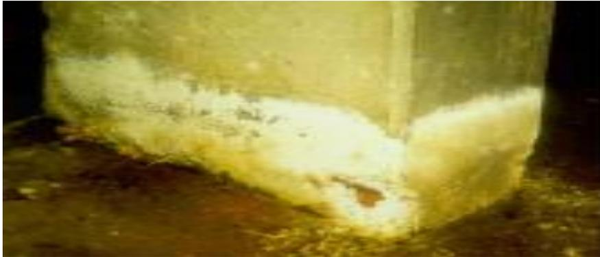
Figure I.2: Attaques sulfatiques à une poutre en béton. [(Itmaizeh E) ,2016]
