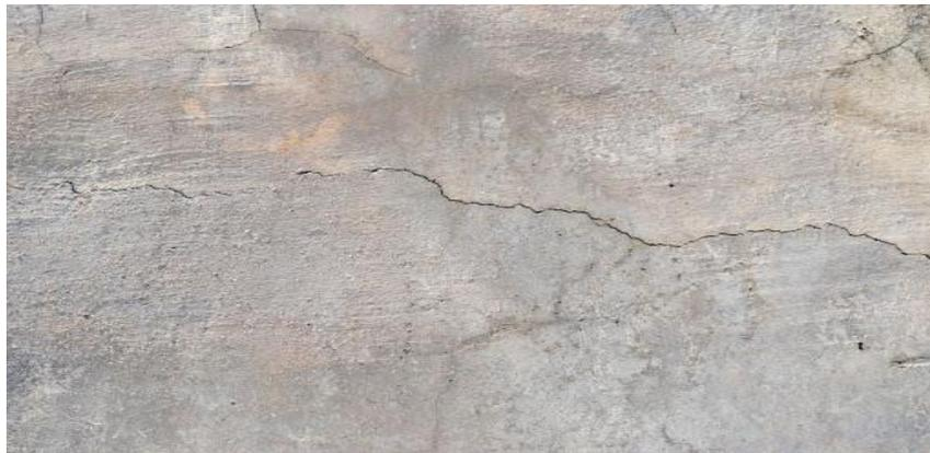
***Figure I.9: Phénomène de faiençage. (Guide béton, 2020)***
