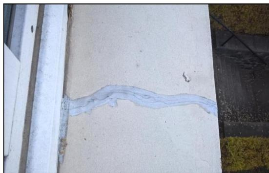
*Figure II.5: Traitement d'une fissure mur en béton. [(A.bricoleur), 2016]*
