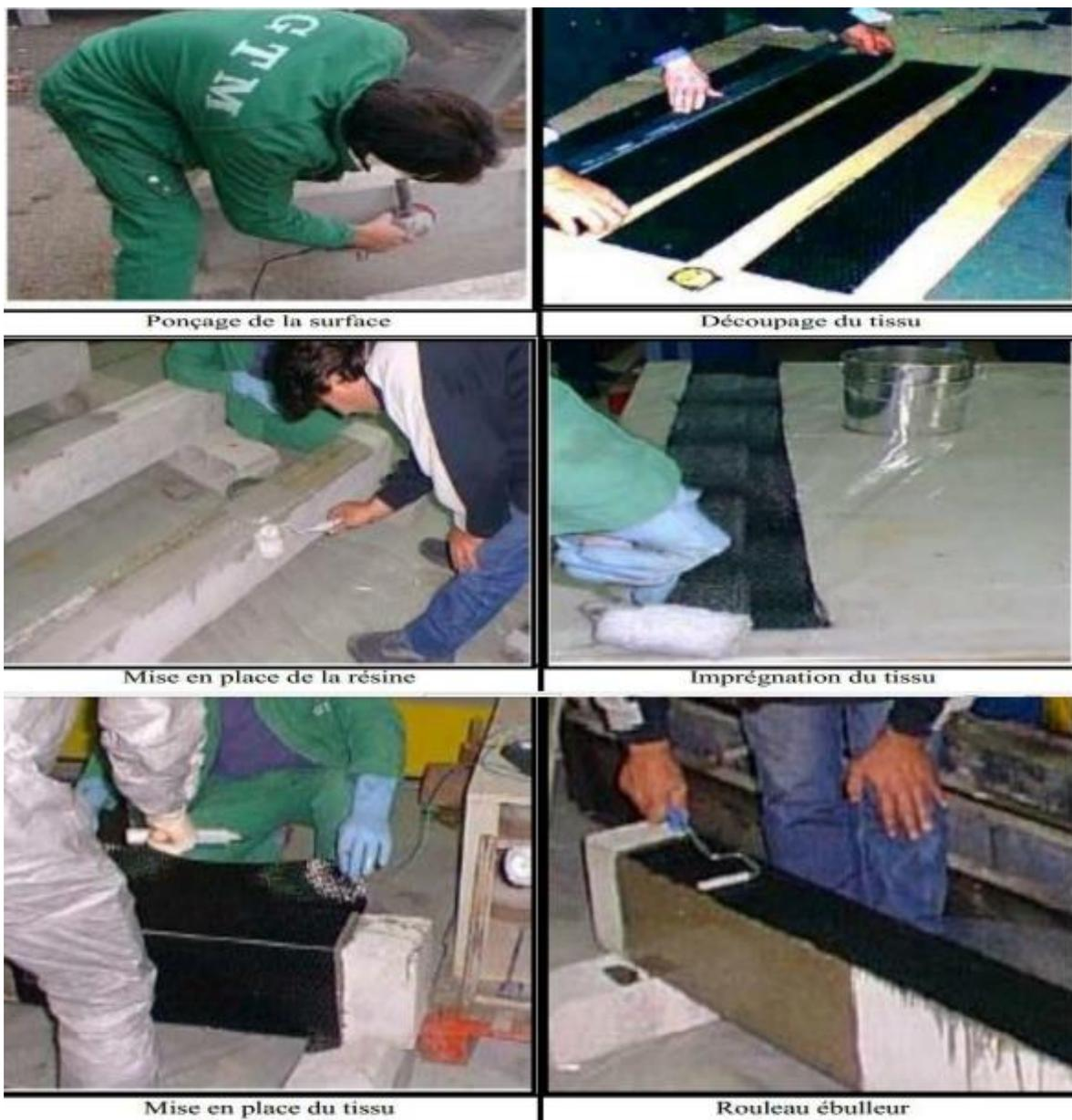
Figure II.15: Mise en œuvre d'une réparation par stratification. [Boulaziz.A.2014]
