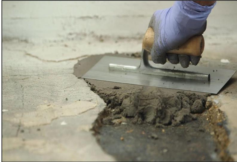
*Figure II.3: Ragréage d'un béton avec un mortier de réparation. [(WATCO Fr) ,2014]*
