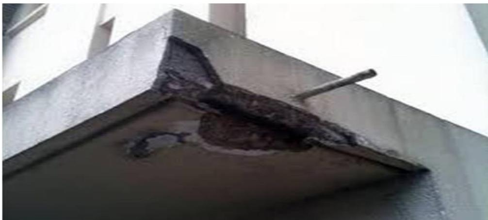
***Figure I.10: Epaufrure dans une construction. [(Itmaizeh E,2016)]***
