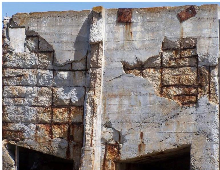
*Figure I.6: Phénomène de corrosion à une structure en béton armé. [(Per Loll),2017]*
