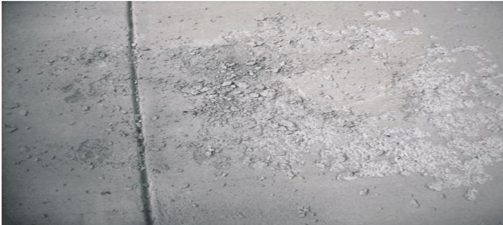
*Figure I.12: Phénomène de ressuage à une surface en béton. [(DSG), 2016]*
