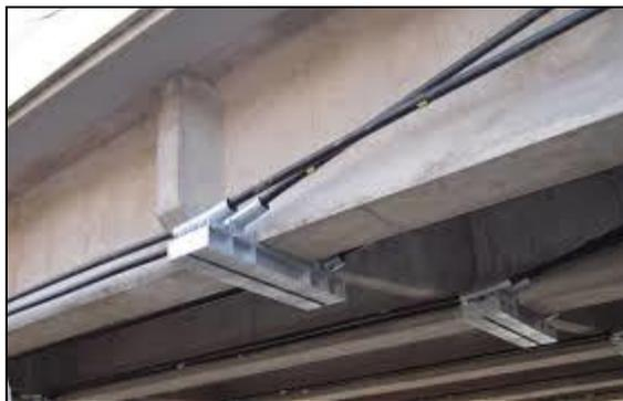
*Figure II.11 : Une réparation par une précontrainte .additionnelle [(Colloque Le Pont), 2017]*
