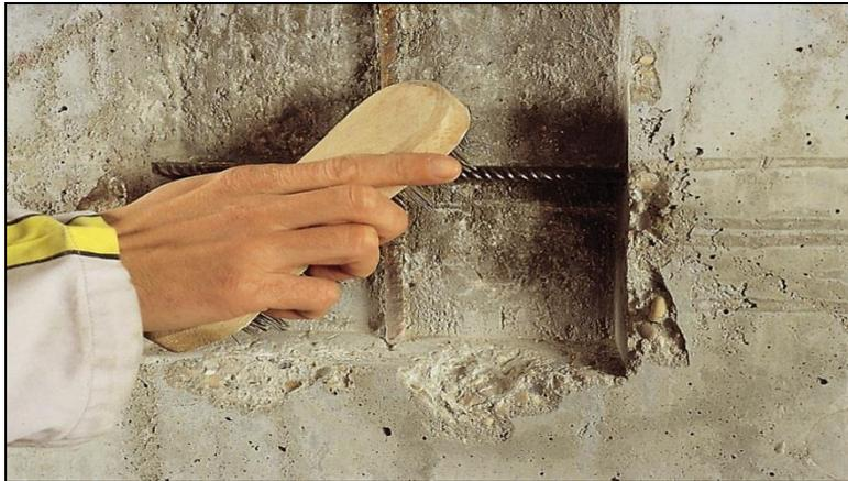
*Figure II.1: Préparation de la surface par une élimination de la rouille et de béton vieux par brosseage [(Weber), 2018]*
