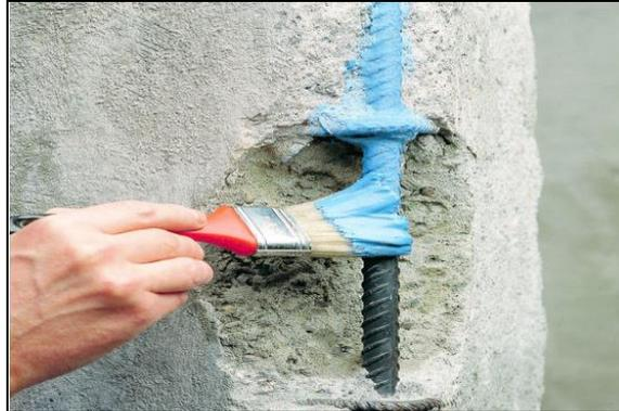
*Figure II.2: une application d'un mortier anticorrosion pour la protection des armatures. [(Mapefer), 2005]*
