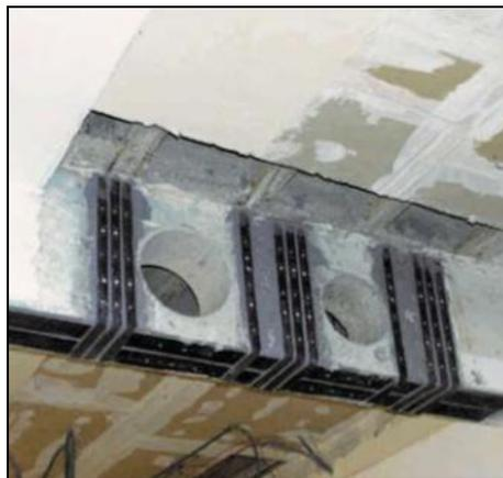
*Figure II.13: renforcement d'une poutre au moyen de matériaux composites.
