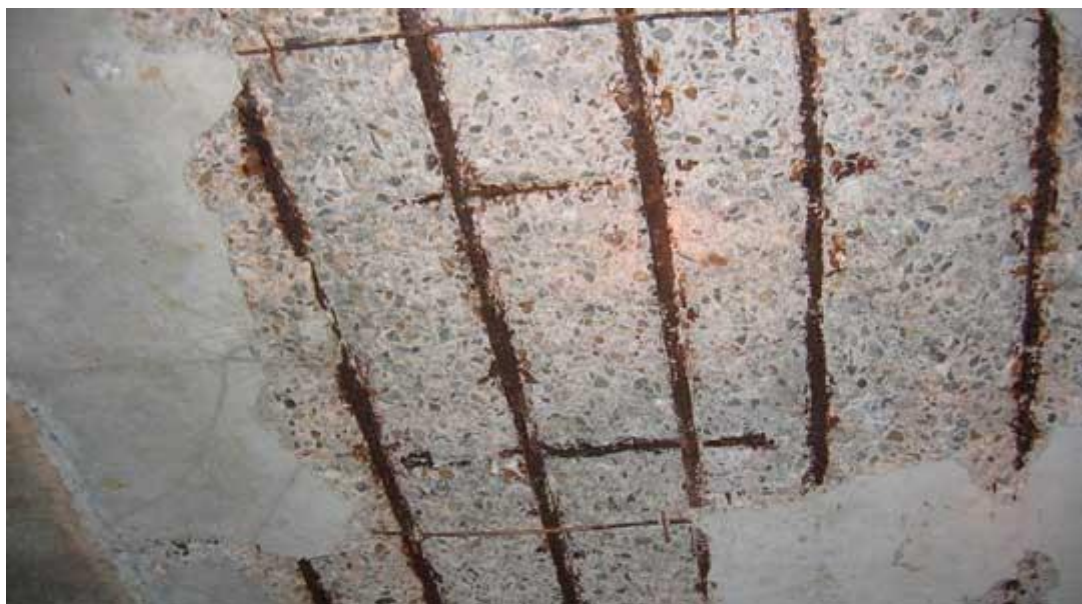
Figure I.5 : Corrosion des armatures métalliques [paddy engineering.2015]
