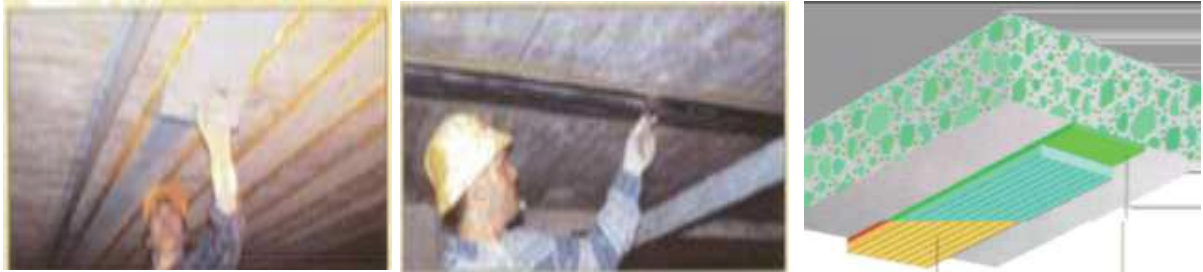
Figure 1.15: Procède Par Collage De Plaques [SIKA, 1996].
