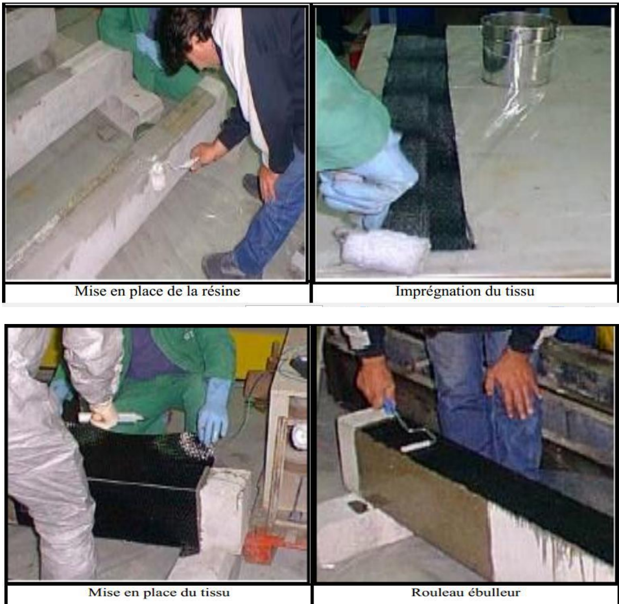
Figure I.16 : Mise en œuvre d'une réparation par stratification [Boulaziz.A.2014].
