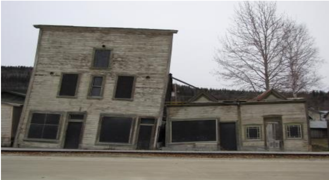
Figure I.9 : tassement différentiel [Ould El Hacem . 2016].
