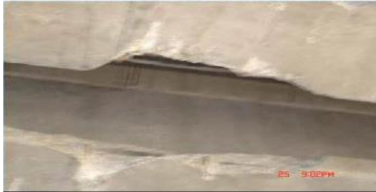
Figure I.6: Dégradation par choc [Hamlaoui Salim. 2012].
